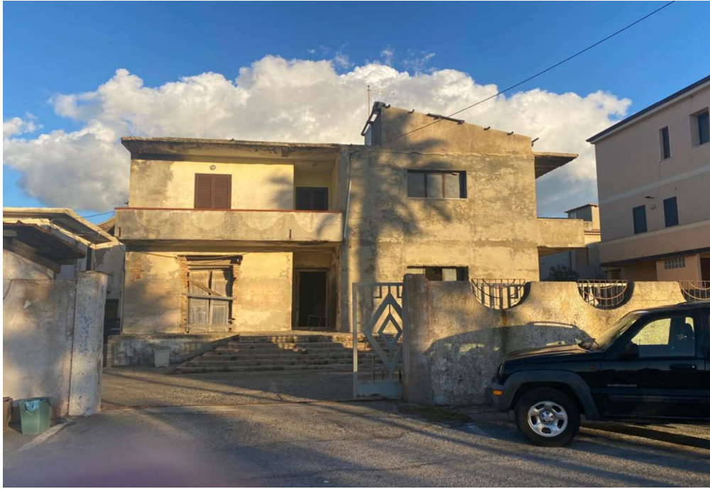
Foto n° 2 Vista esterna da via Lungomare
