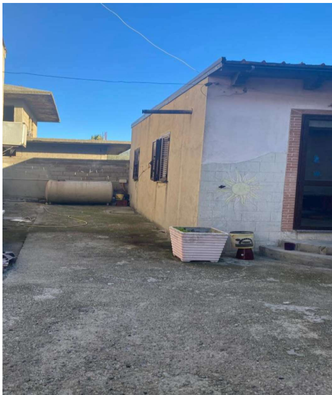
Foto n. 21 manufatto abusivo e parte di corte
