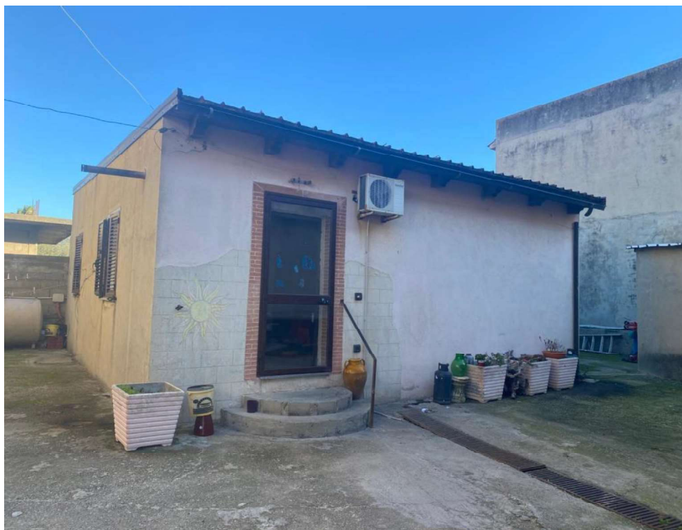
Foto n. 20 Manufatto abusivo non sanabile, adibito ad abitazione adibito ad abitazione
