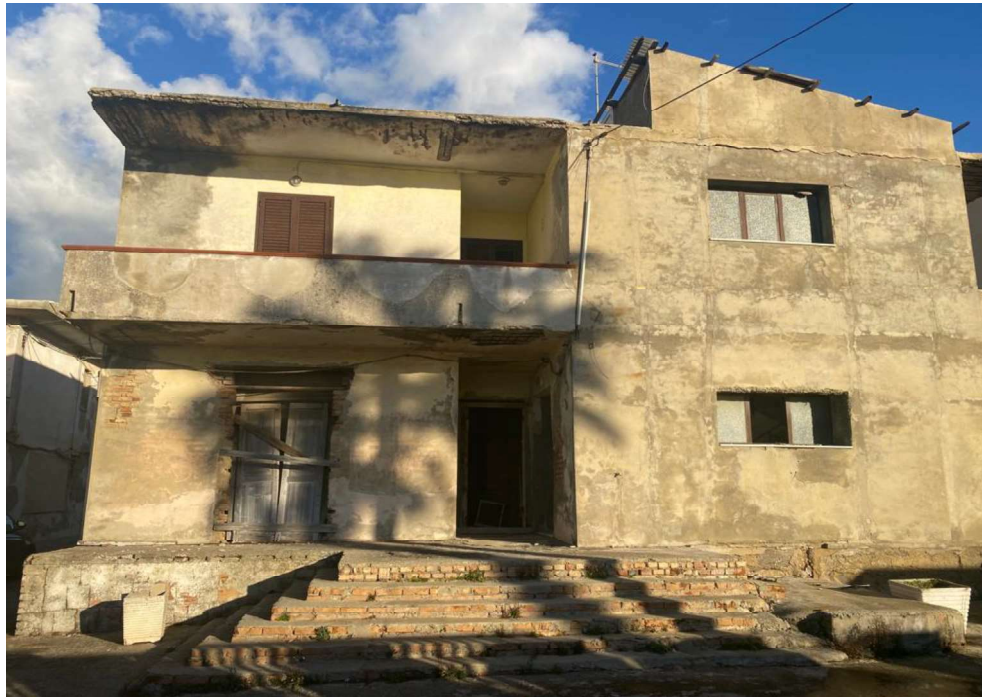
Foto n° 3 Vista esterna da via Lungomare
