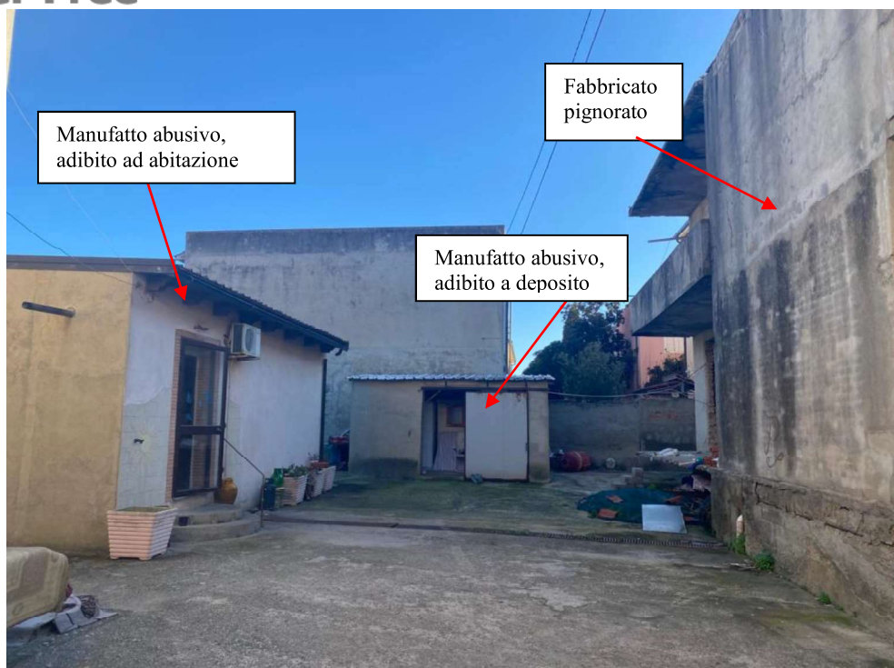
Foto n. 19 Manufatti abusivi non sanabili
