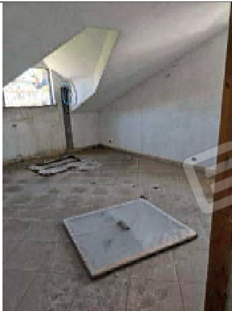
foto 49. Dettaglio appartamento sub. 11 part. 1096
