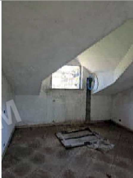
foto 51. Dettaglio appartamento sub. 11 part. 1096
