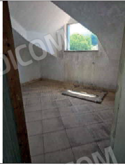
foto 47. Dettaglio appartamento sub. 11 part. 1096
