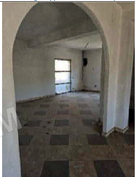
foto 33. Dettaglio appartamento sub. 11 part. 1096
