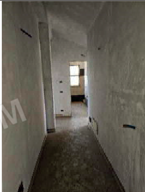
foto 45. Dettaglio appartamento sub. 11 part. 1096
