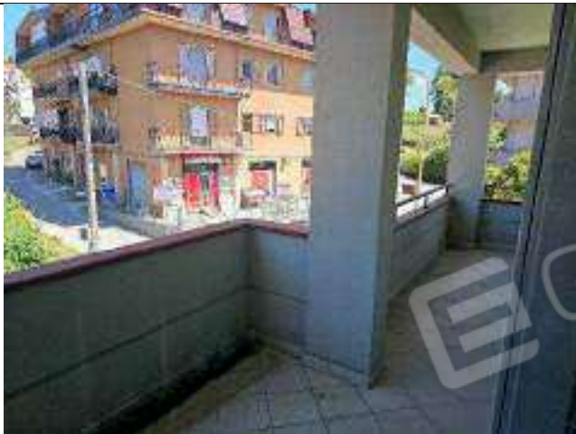
foto 37. Dettaglio appartamento sub. 11 part. 1096
