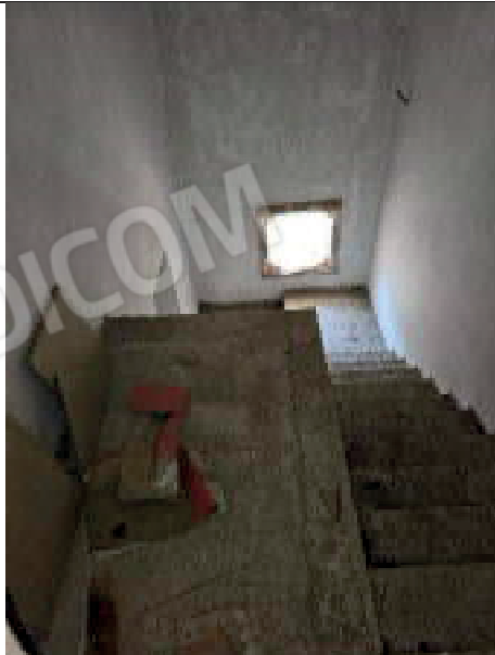
foto 53. Dettaglio appartamento sub. 11 part. 1096
