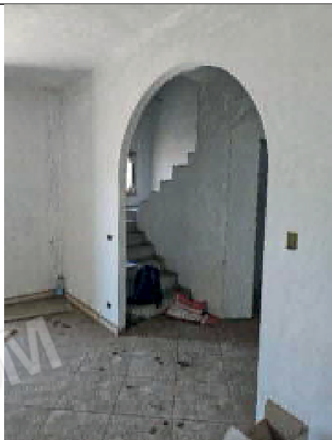
foto 39. Dettaglio appartamento sub. 11 part. 1096
