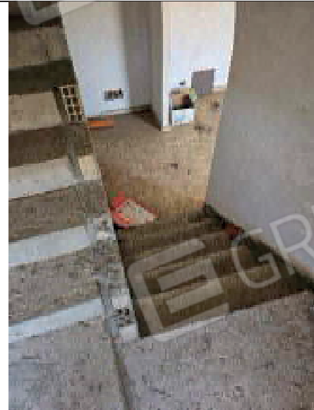
foto 54. Dettaglio appartamento sub. 11 part. 1096
