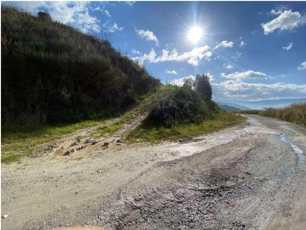
In evidenza, accesso da SP alla strada interpoderale
