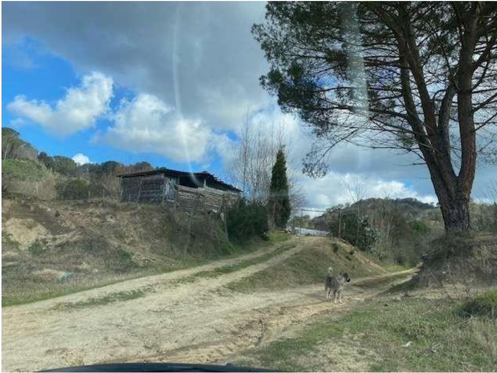
Fig. 14 Deposito sulla particella 60
