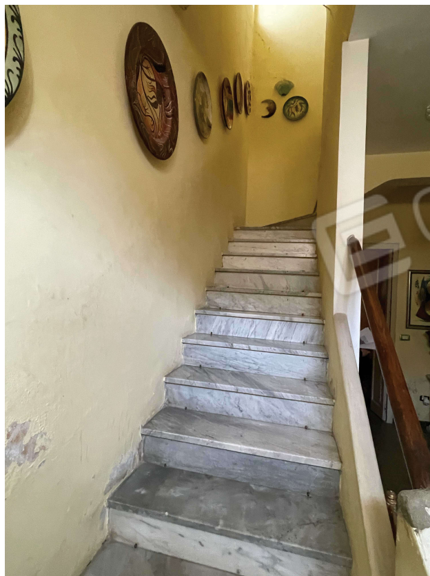
Foto 4 N.C.E.U. Sant'Onofrio fg. 6 - p.lla 724 sub 2
