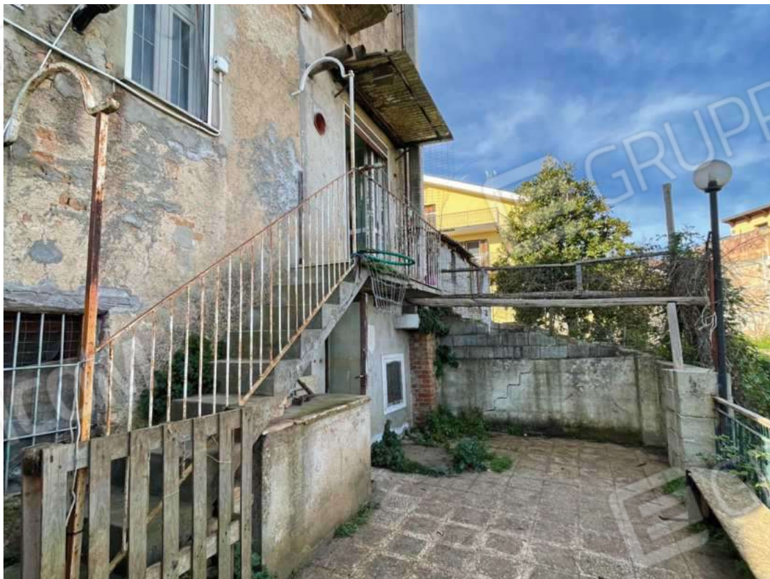
Foto 10 N.C.E.U. Sant'Onofrio fg. 6 - p.lla 724 sub 2 cortile
