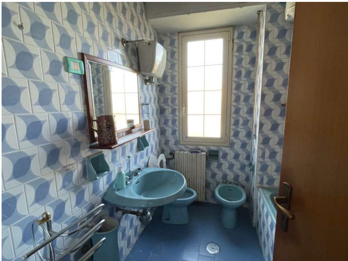
Foto 6 N.C.E.U. Sant'Onofrio fg. 6 - p.lla 724 sub 2
