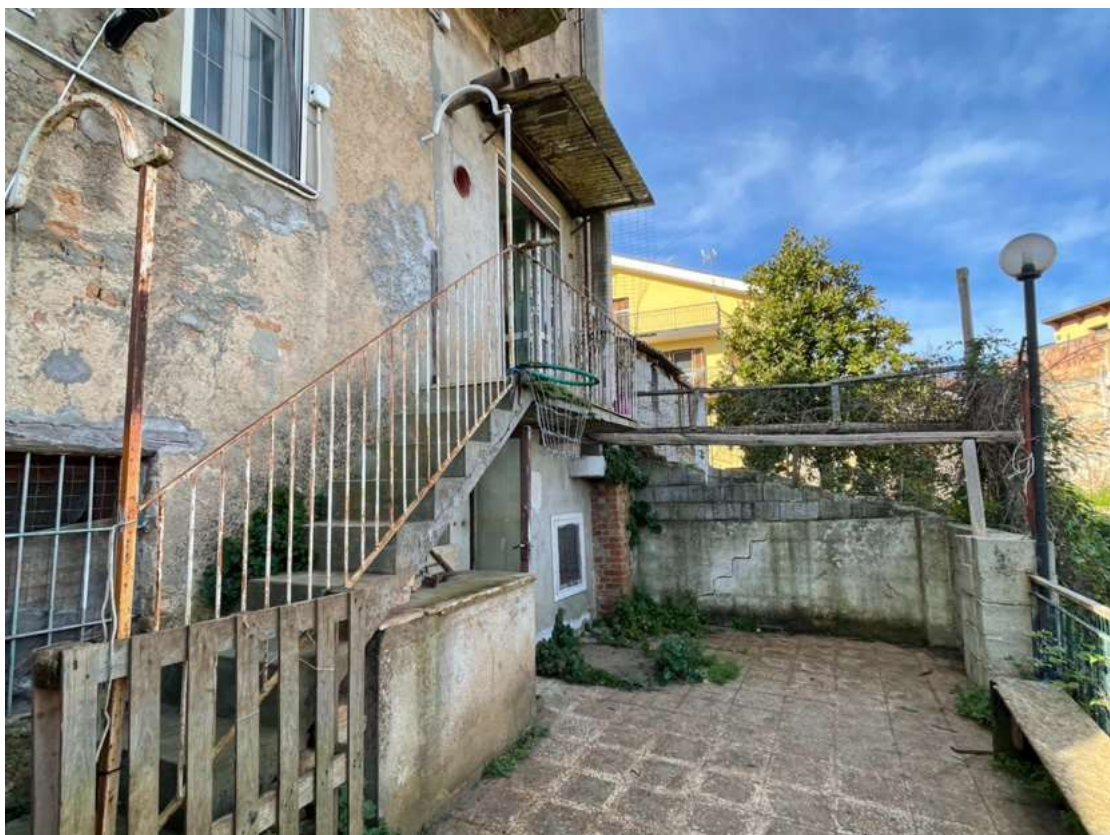
Foto 10 N.C.E.U. Sant'Onofrio fg. 6 - p.lla 724 sub 2 cortile
