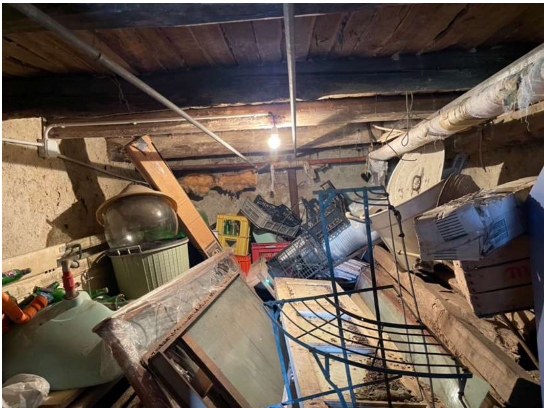
Foto 12 N.C.E.U. Sant'Onofrio fg. 6 - p.lla 724 sub 2 cortile (seminterrato)
