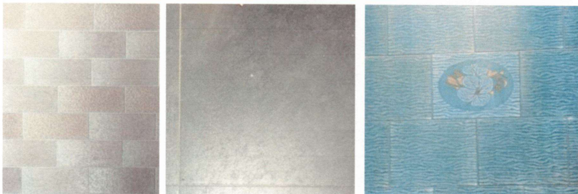
Da sx verso dx: Pavimenti balconi, Pavimenti interni, Rivestimento bagno padronale. (Allegato 8 - Rilievo fotografico).
