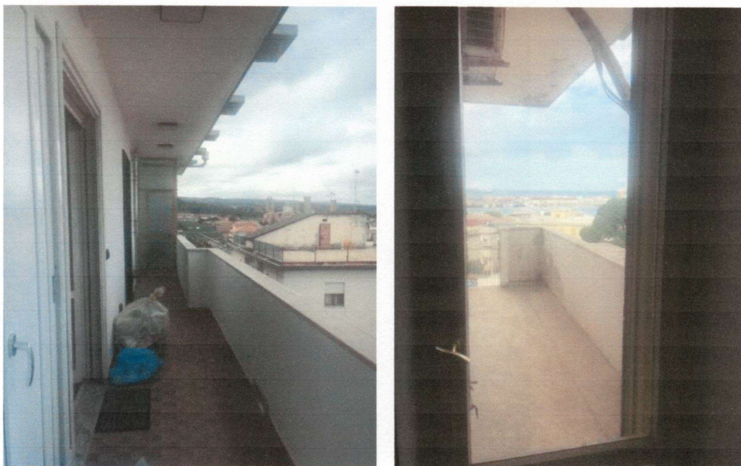
Balcone - Area cucina/pranzo (a sx). Balcone seconda camera da letto (in alto a dx). (Allegato 8 - Rilievo fotografico).
