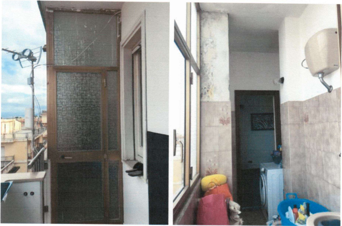
Chiusura balcone con pannellatura in alluminio anodizzato e vetro.
