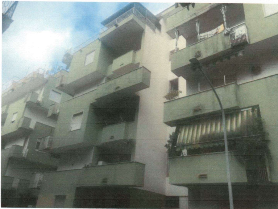
Esterno fabbricato, Palazzina A/2. Allegato 8 - Rilievo fotografico.
