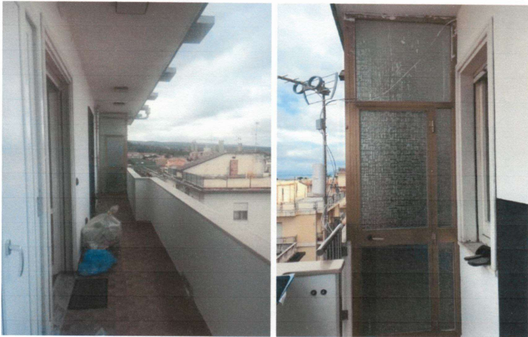
Balcone soggiorno-cucina/camera da letto padronale (in alto a sx). Secondo bagno (difformità) - Struttura in alluminio vetrata (in alto a dx). (Allegato 8 - Rilievo fotografico).
