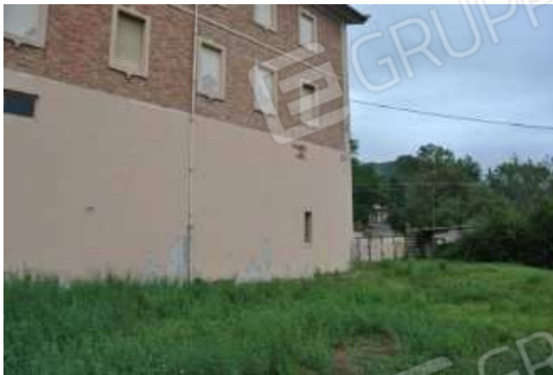
Foto 5 – Lotto 1, corpo A, vista dall'interno della corte, prospetto lato SUD
