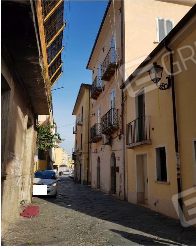
Foto 2_ Affacci su via Port'Arsa (piano 1)
