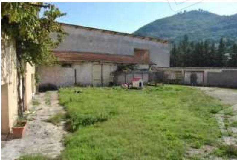
Foto 12 – Lotto 1, corpo B e C, vista dall'interno della particella 637, prospetto lato OVEST
