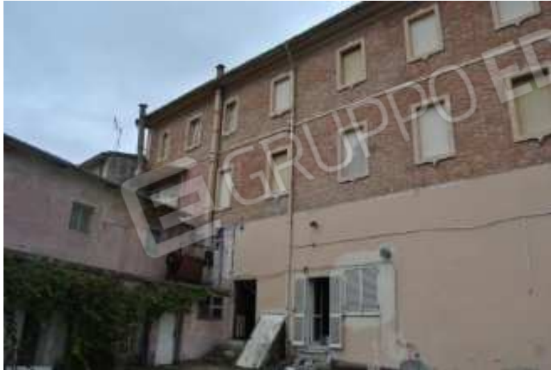
Foto 4 – Lotto 1, corpo A, vista dall'interno della corte, prospetto lato SUD
