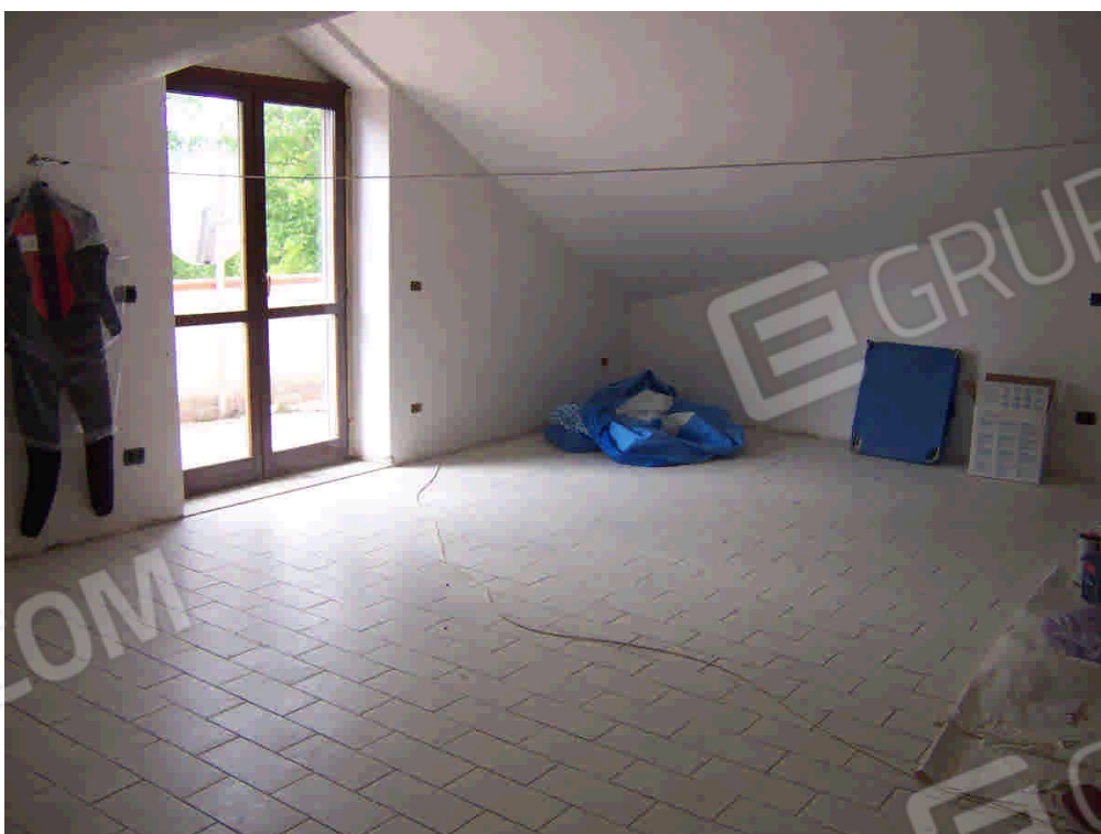
FOTO N. 38 Altro particolare del locale di sgombero.
