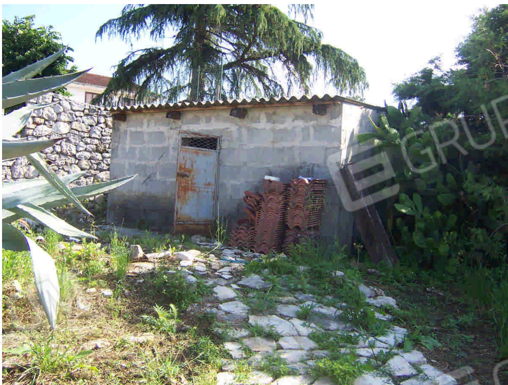
FOTO N. 8 Prospetto del locale adibito a legnaia, non accatastato, insistente sull'appezzamento di terreno di cui alla particella 791.
