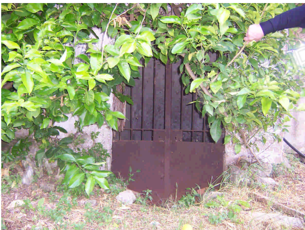
FOTO N. 4 Questo l'accesso al piano interrato del fabbricato di cui alla particella 929.
