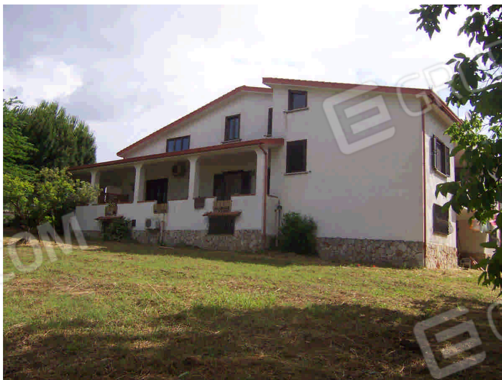
FOTO N. 12 Altro prospetto del fabbricato
