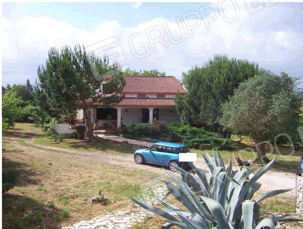
FOTO N. 11 Prospetto del fabbricato
