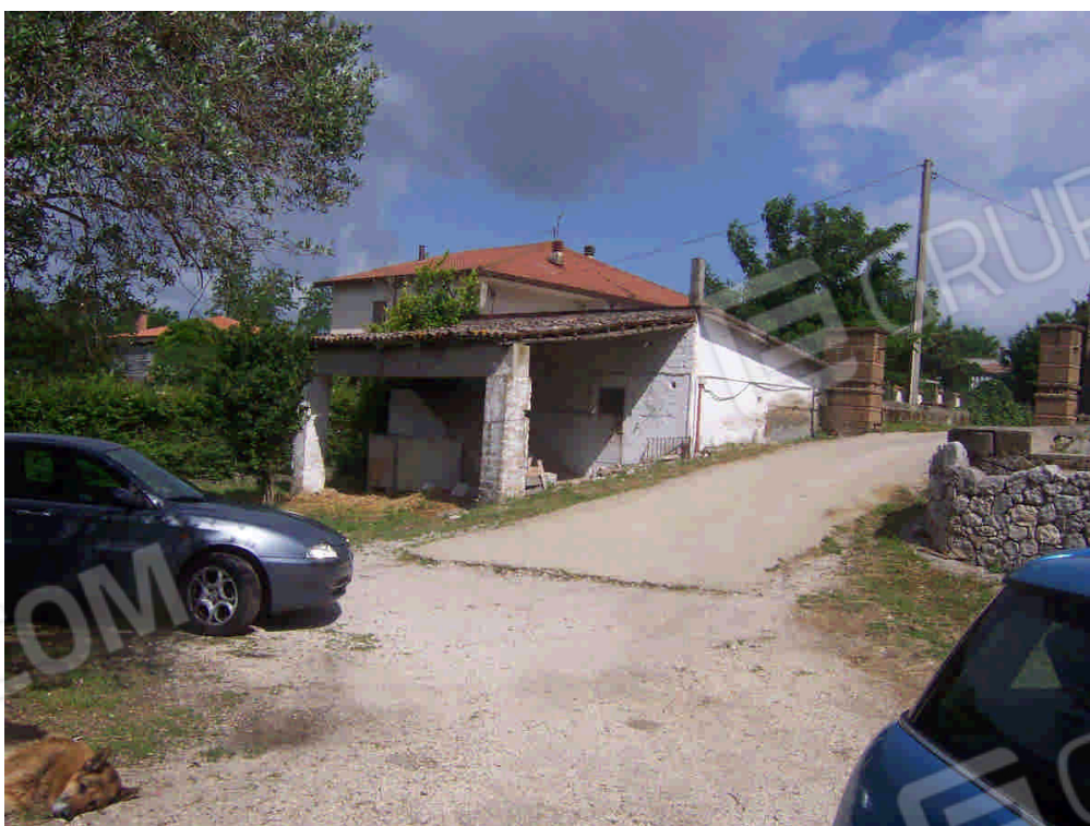
FOTO N. 2 Questo il fabbricato di cui alla particella 929.
