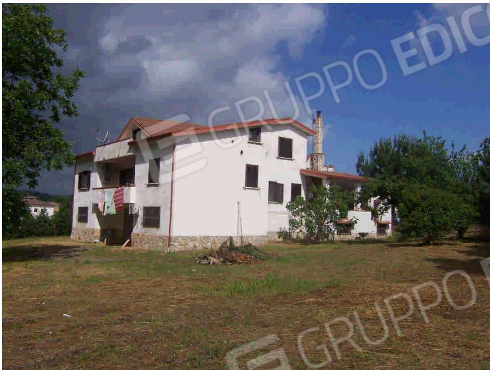
FOTO N. 13 Altro prospetto del fabbricato PIANO SEMINTERRATO
