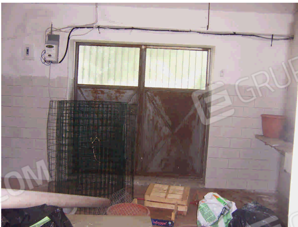
FOTO N. 6 Particolare del locale adibito a deposito al piano terra.
