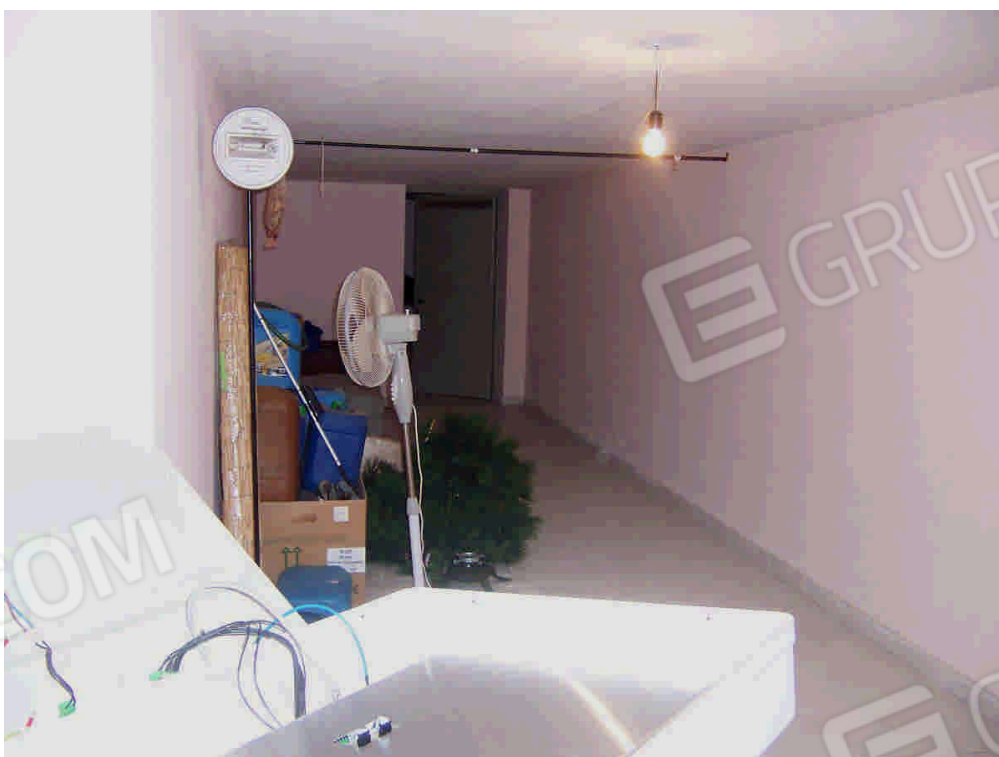
FOTO N. 16 Dettaglio del locale adibito a deposito.
