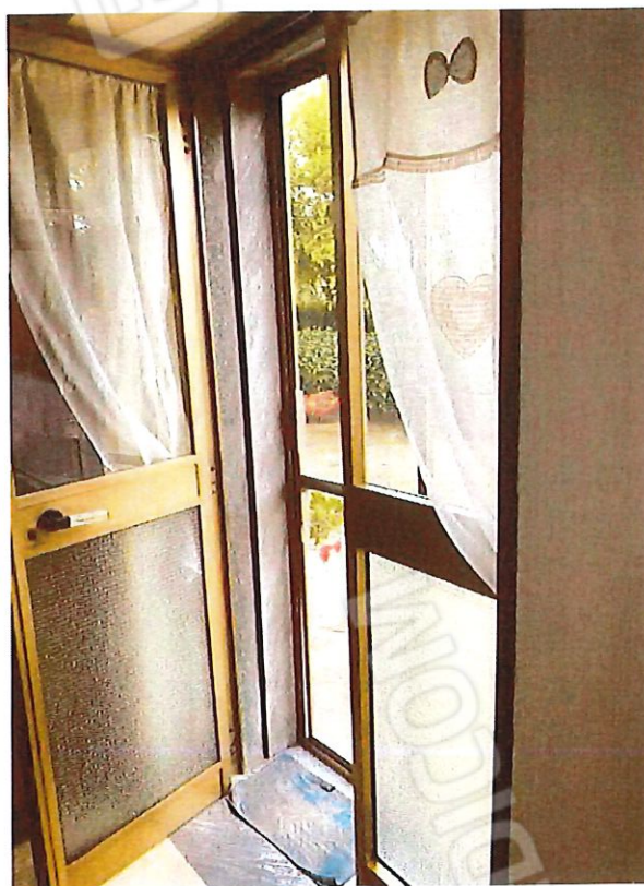
Foto 10 – Portone d'ingresso al vano cucina soggiorno del sub 5 della particella 345
