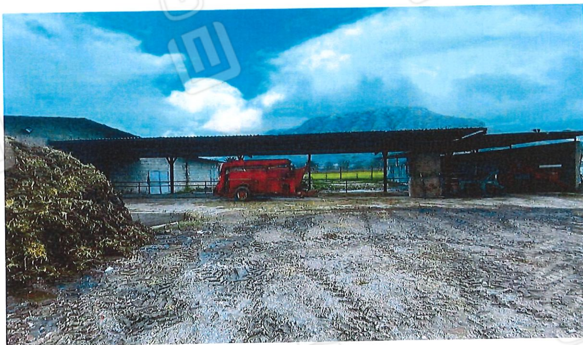
Foto 20 – Vista del Corpo 1 della particella 1064 sub 1
