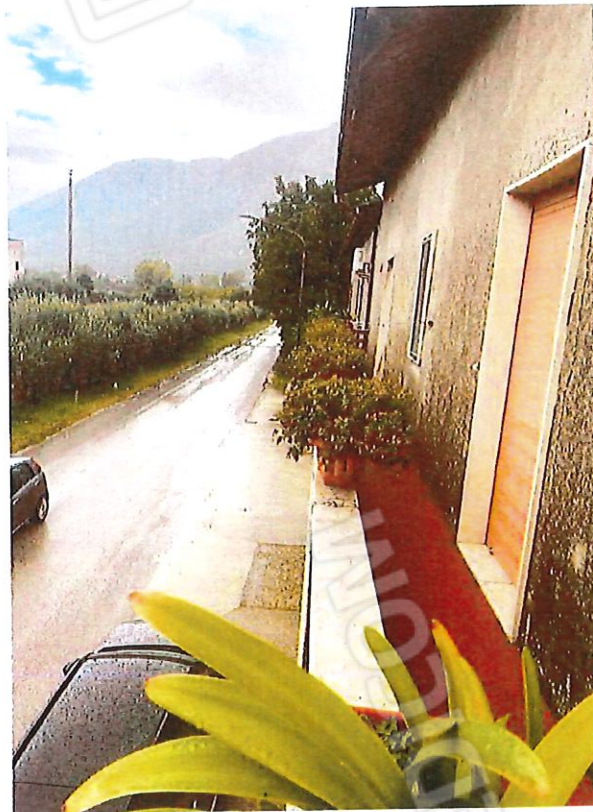
Foto 14 – Dettaglio del balcone lato OVEST del sub 5 della particella 345
