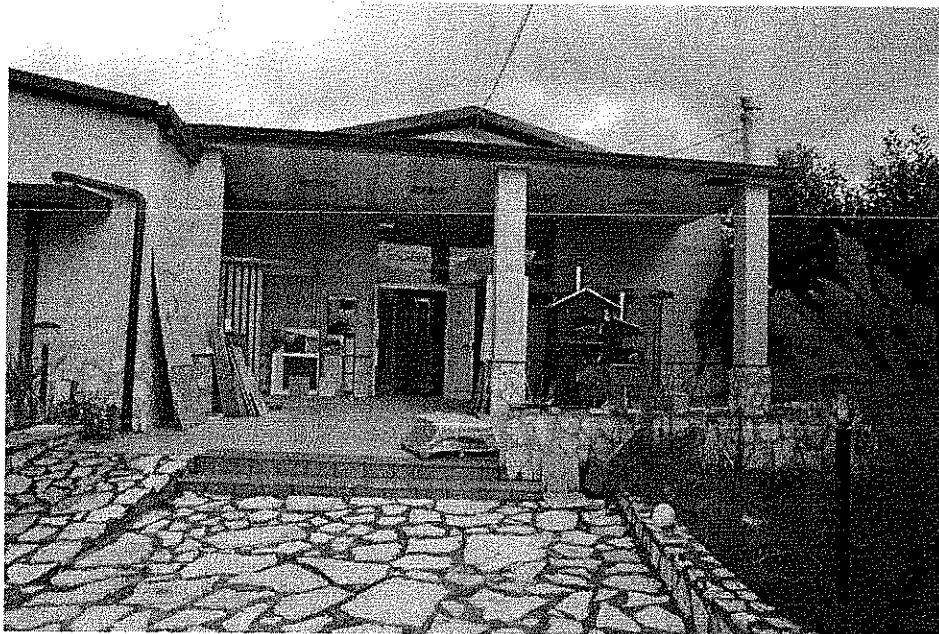
Foto 10 – Fabbricato p.la 443: ingresso al deposito
