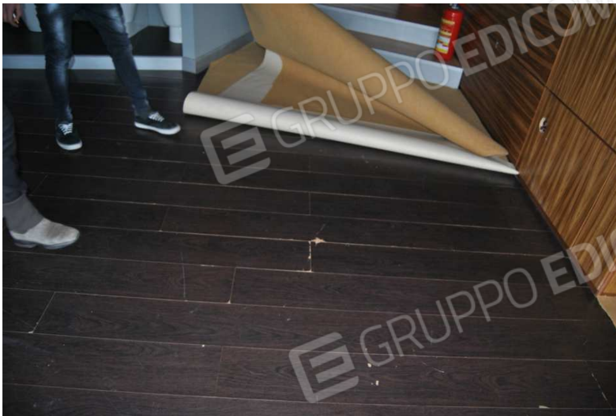
Foto 13 – 21.01.2016 – Area d'ingresso al fabbricato p.IIa 442 con vista del parquet coperto dal tappeto in juta
