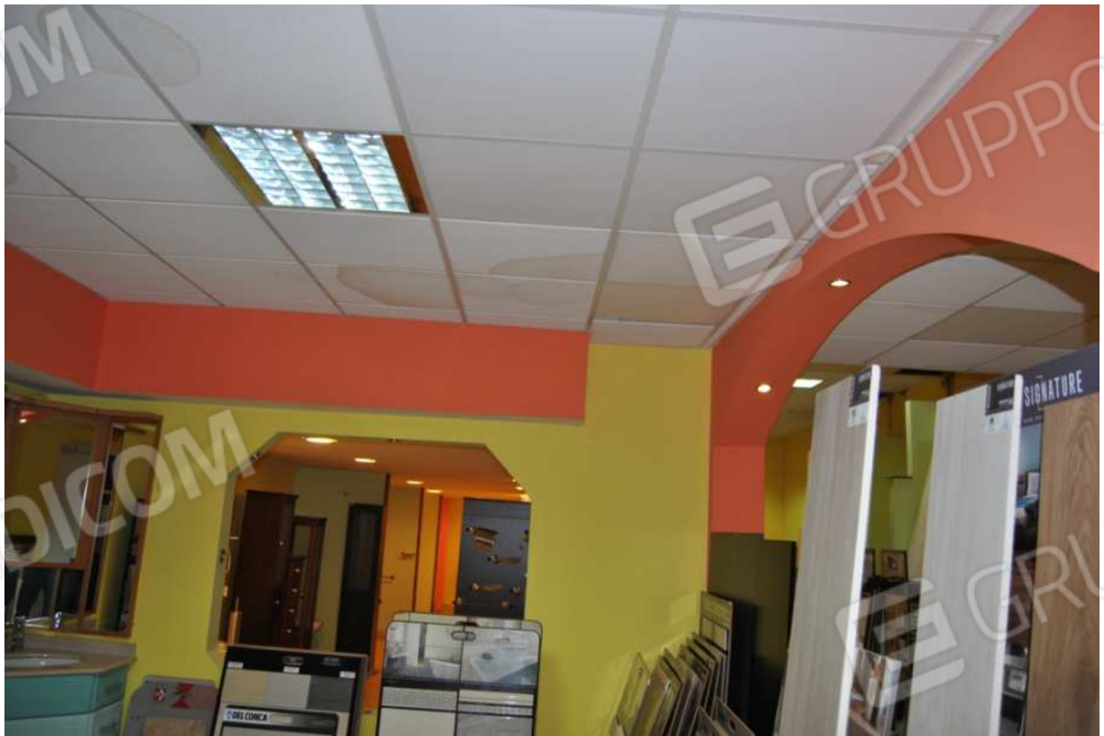
Foto 44 – 21.01.2016 – Area espositiva nel volume abusivo: vista della controsoffittatura con pannelli attaccati da fenomeni di muffa
