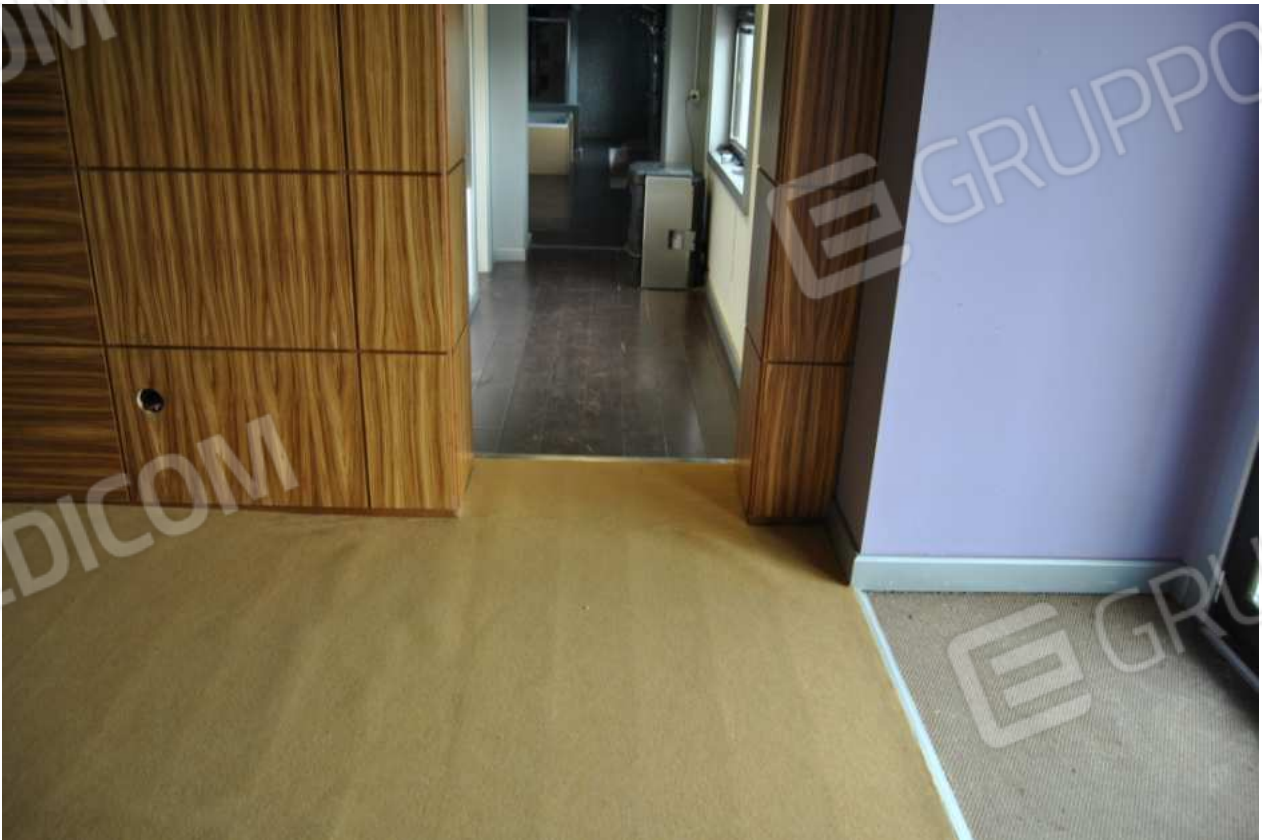
Foto 12 – 21.01.2016 – Area d'ingresso al fabbricato p.la 442 con vista del tappeto in juta e dell'accesso all'area amministrativa/commerciale
