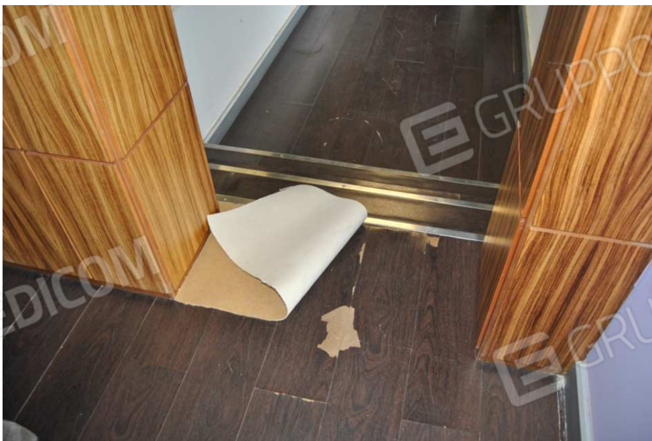
Foto 14 – 21.01.2016 – Area d'ingresso al fabbricato p.IIa 442 e di accesso all'area amministrativa/commerciale
