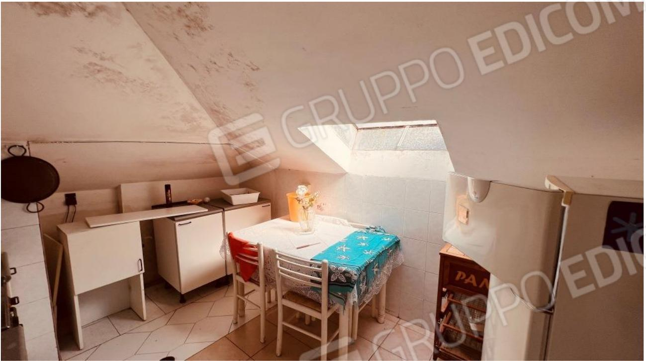
Foto 10 – Vano cucina con lucernaio e macchie d'umidità
