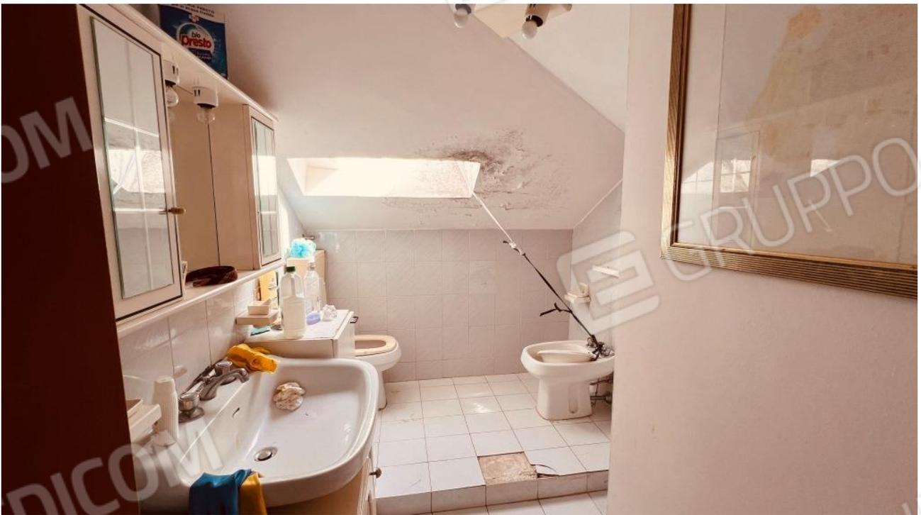
Foto 11 – Vano bagno con lucernaio e macchie d'umidità
