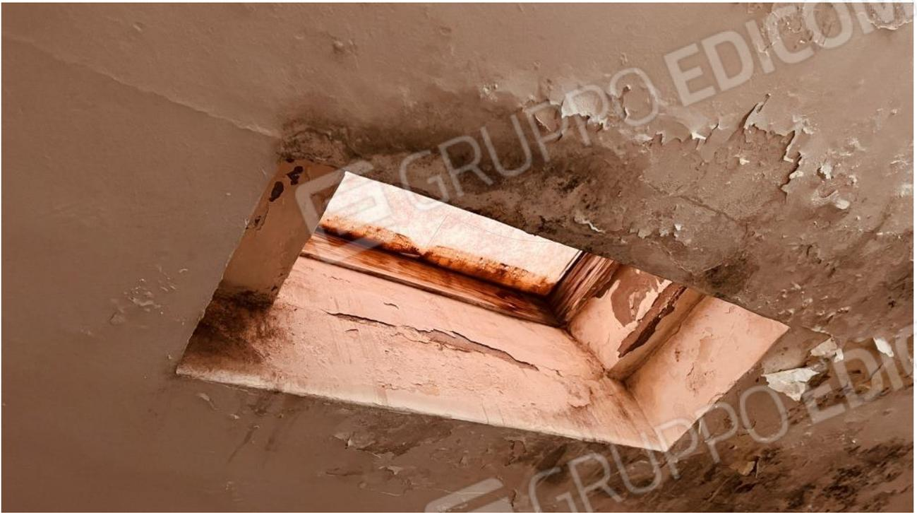
Foto 6 – Dettaglio macchie di umidità intorno al lucernaio dell'ingresso/soggiorno
