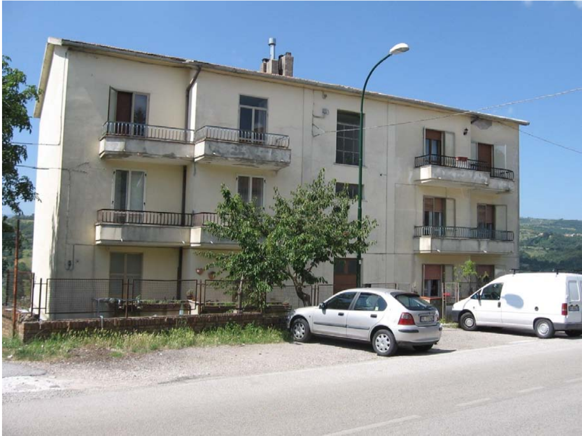
Foto 1 – Prospetto principale su Via Falcone e Borsellino
