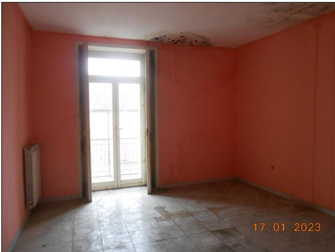
**FOTO N. 43 Vista interna del piano primo. Si notano diffuse infiltrazioni sul soffitto e l'acqua sul pavimento**
