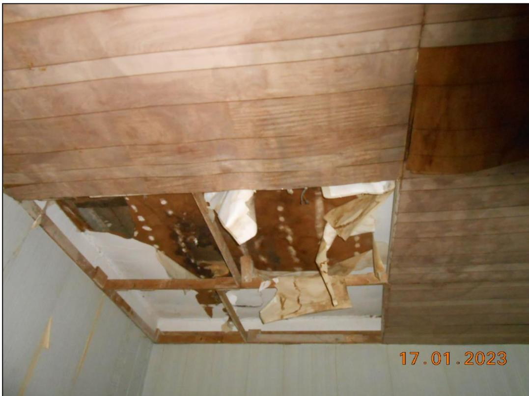
**FOTO N. 41** Vista interna del piano primo. Si nota la controsoffittatura dei solai e le diffuse infiltrazioni.
