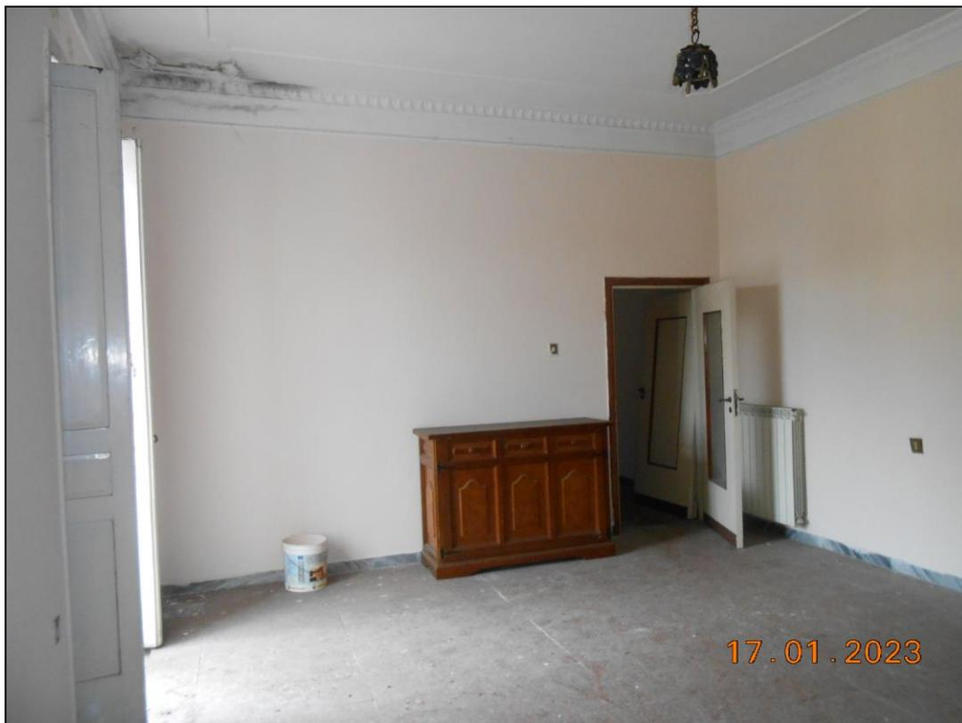
**FOTO N. 51 Vista interna del piano primo. Si notano le infiltrazioni nel soffitto.**
