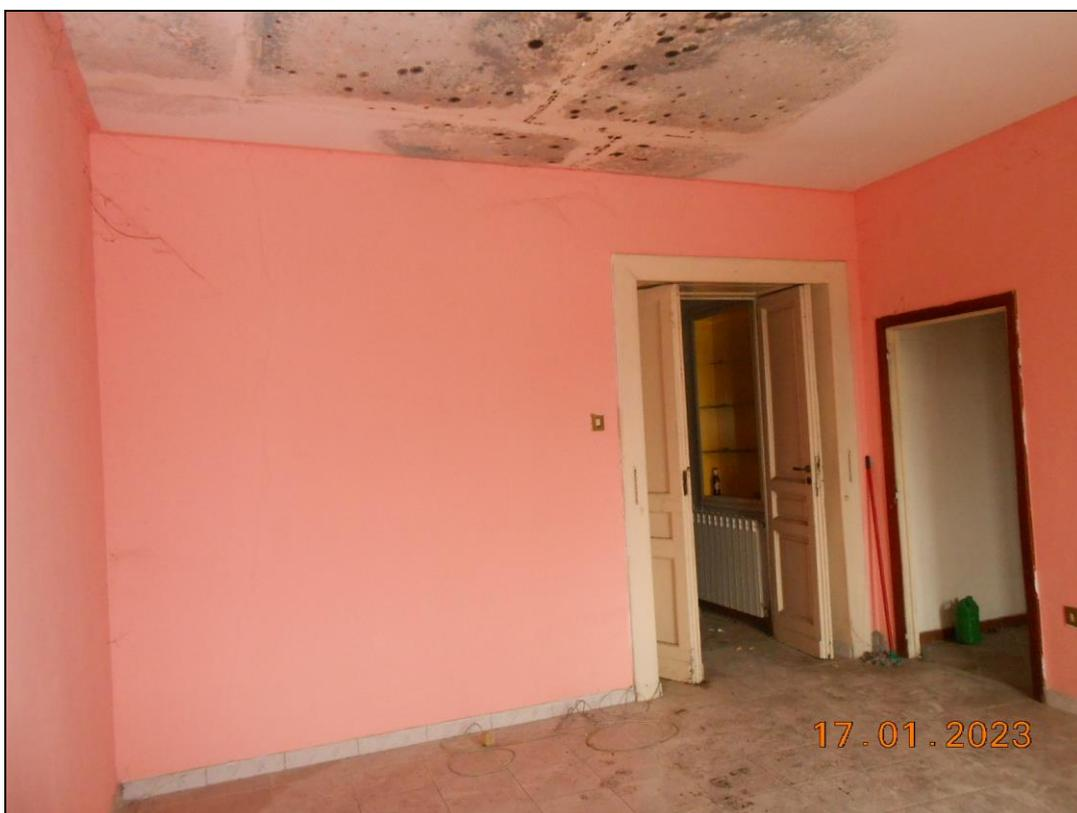
**FOTO N. 42** Vista interna del piano primo. Si notano le diffuse infiltrazioni d'acqua sul soffitto
