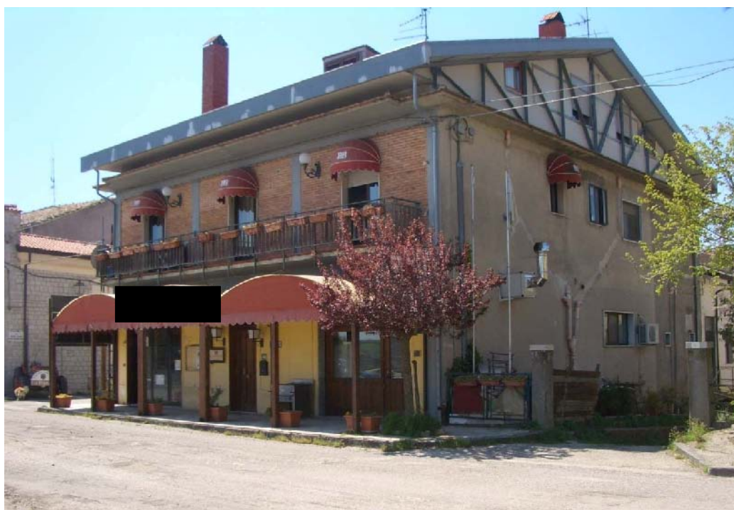
Foto n. 1: ... Scorcio del fabbricato dal V.le Europa ...
