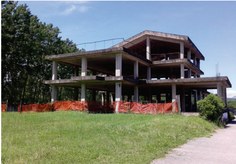
Fig.4 Edificio in corso di costruzione
