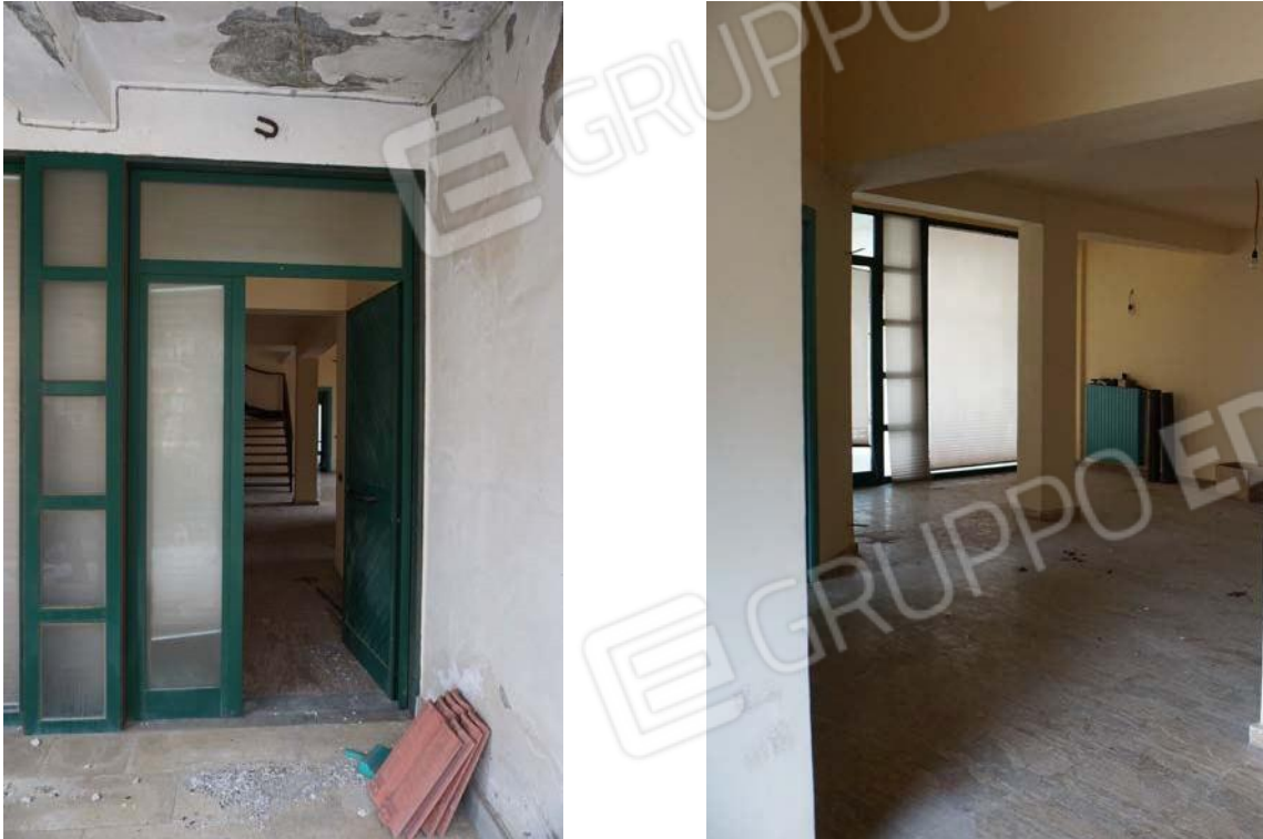
Figg.47-48 – Vista dell’ingresso e del vano d’ingresso dell’immobile al sub.12
