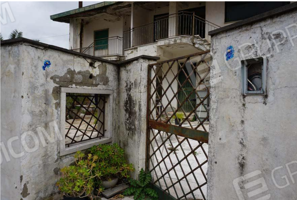
Fig.5 – Vista accesso alla proprietà da Viale dei Pini
