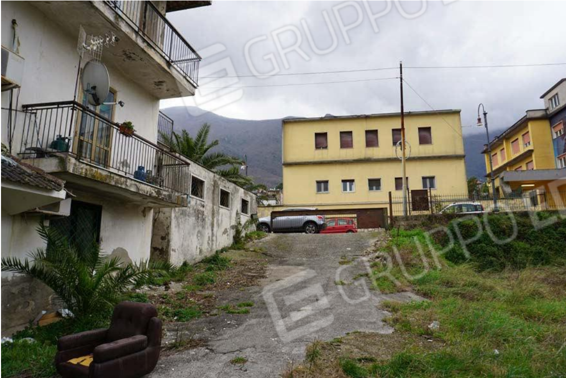
Fig.14 – Vista dell'accesso a Viale dei Pini dell'immobile al foglio 16, p.lla 642, sub.7 (A10)
