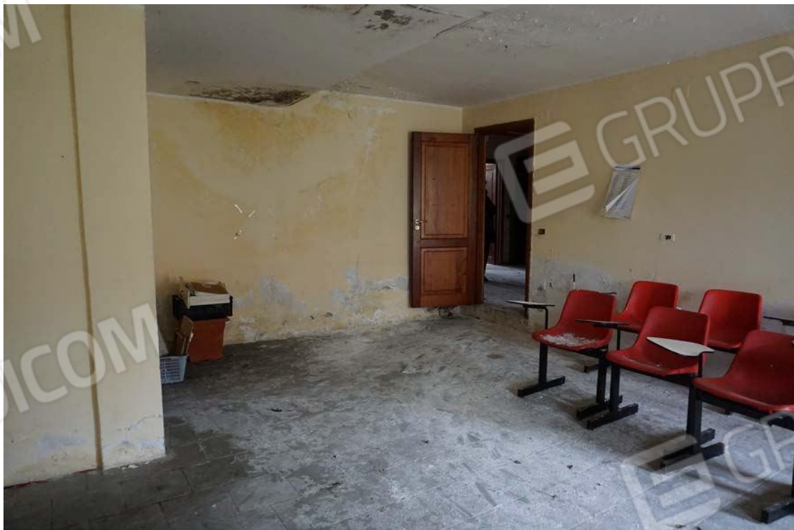
Fig.17 –Vista vano interno sub.7 (A10)
