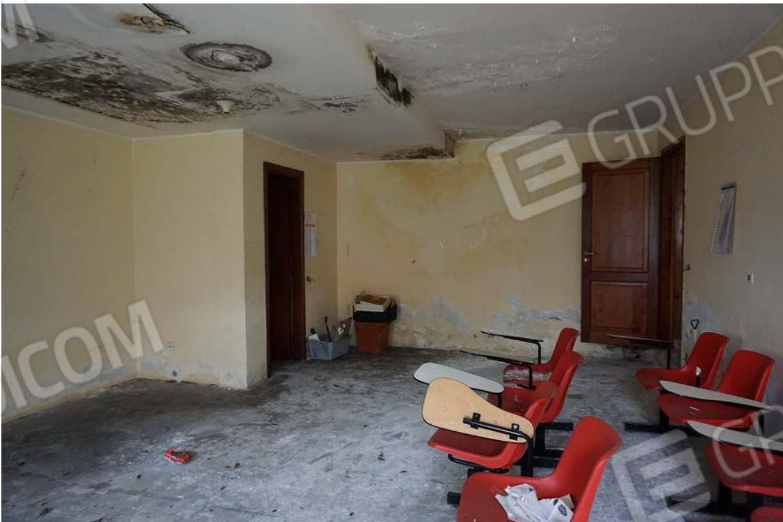
Fig.19 – Vista vano interno sub.7 (A10)
