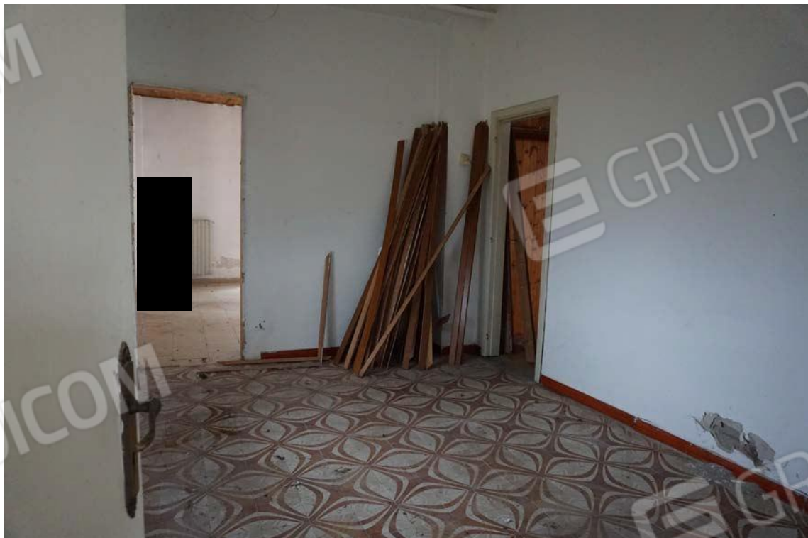
Fig.24 – Vista vano interno dell'immobile sub.9 (A10)
