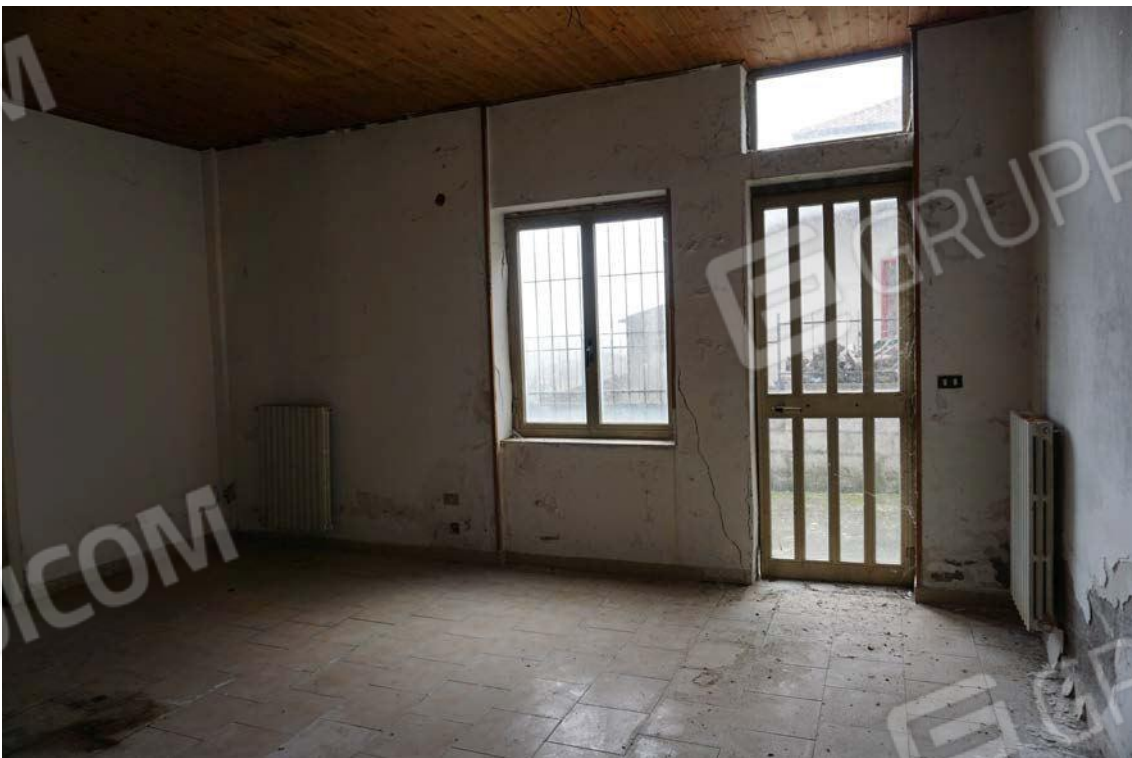
Fig.26 – Vista secondo ingresso dell’immobile sub.9 (A10)
