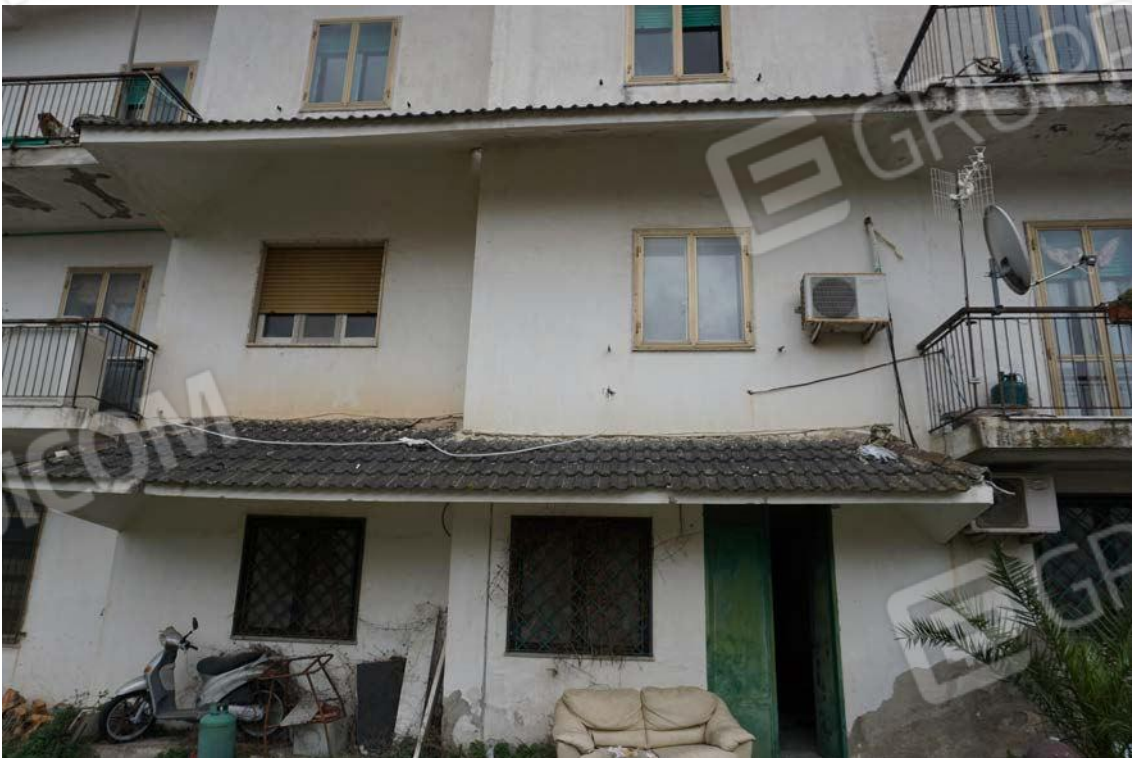
Fig.15 – Vista ingresso dell'immobile sub.7 (A10)
