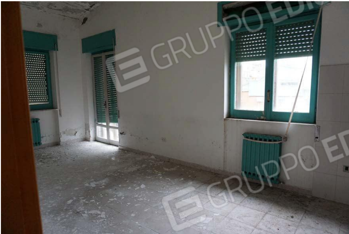
Fig.73 – Vista dell’immobile al sub.13 (A10)
