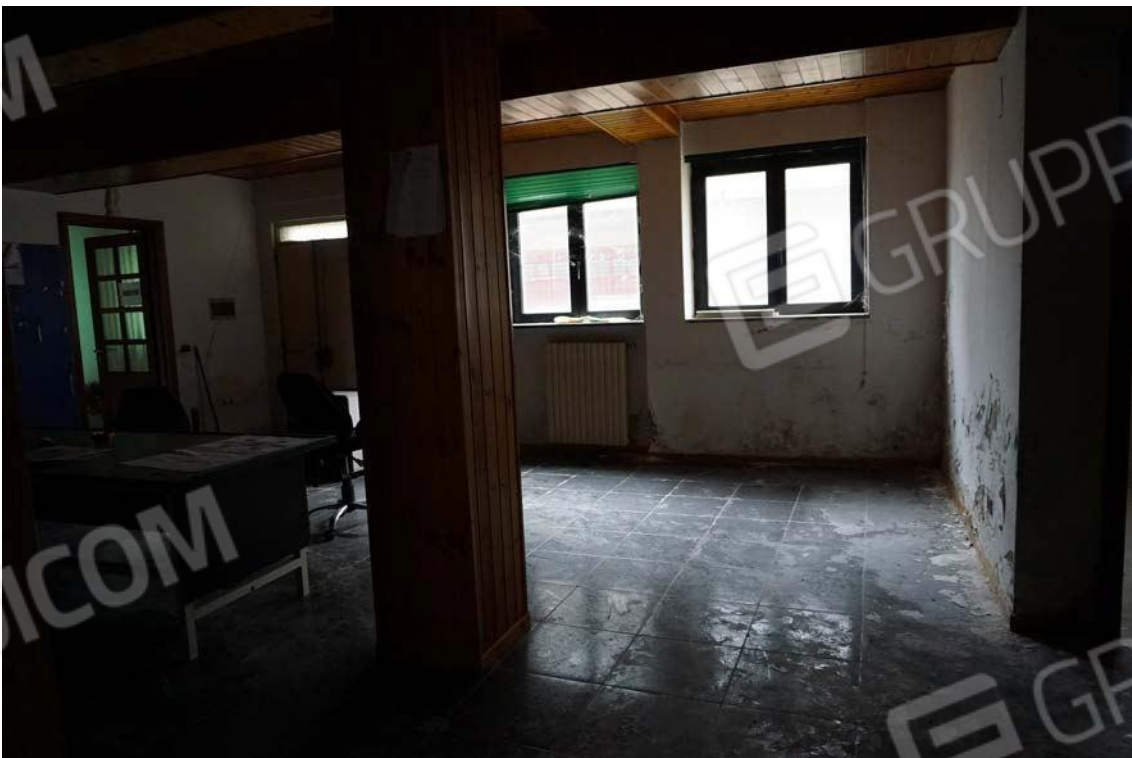
Fig.30 – Vista vano uso ufficio dell'immobile sub.9 (A10)
