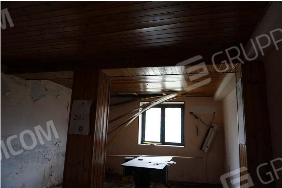
Fig.32– Vista su vano interno dell’immobile sub.9 (A10)
