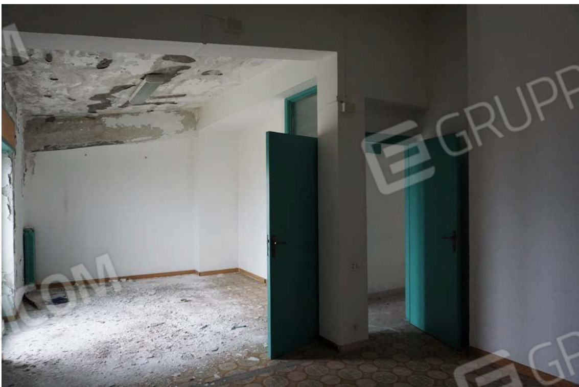
Fig.72 – Vista sala dell'immobile al sub.13 (A10)
