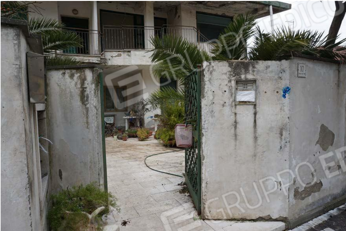
Fig.4 – Vista accesso alla proprietà da Viale dei Pini
