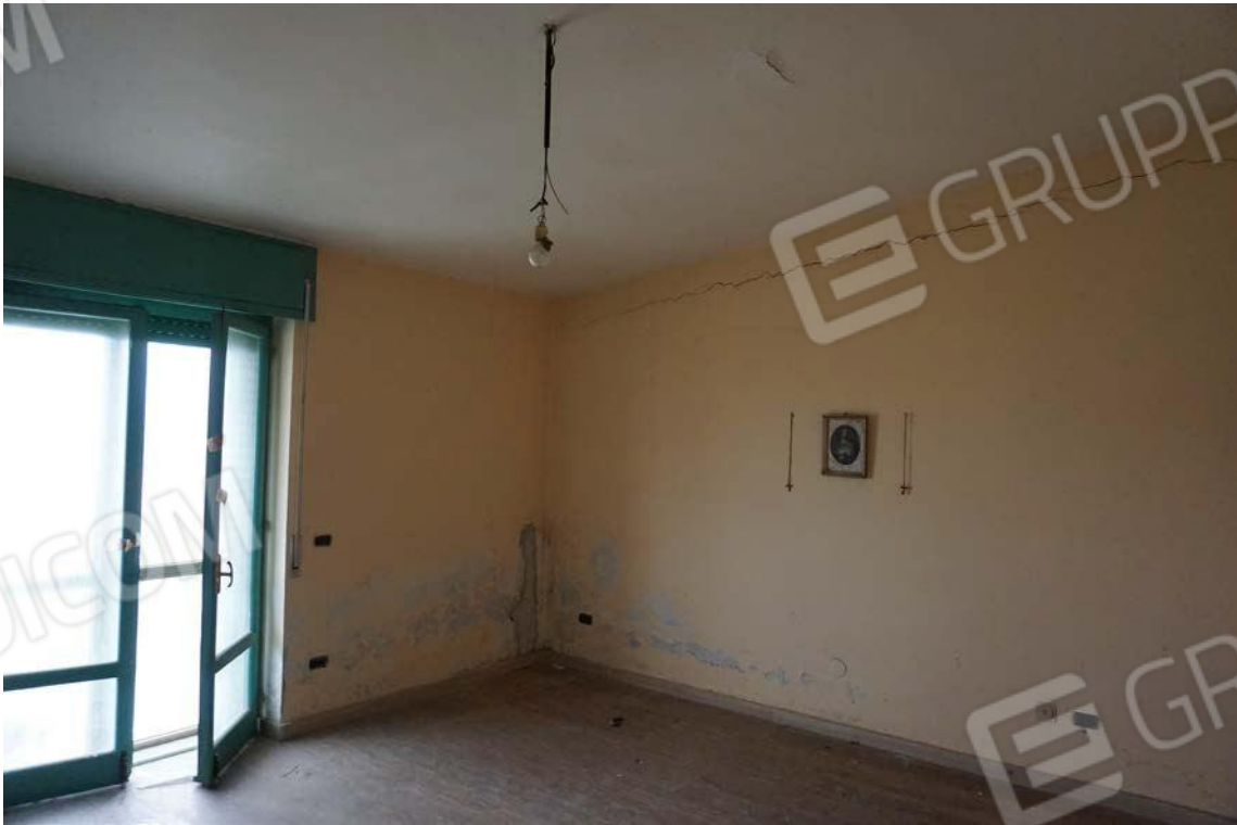
Fig.53 – Vista su vano interno dell'immobile al sub.12
