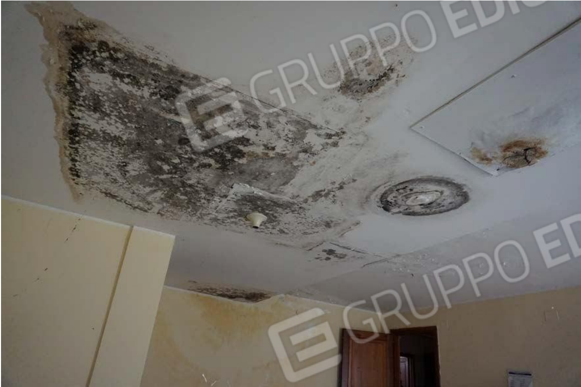
Fig.18 – Vista vano interno sub.7 (A10)
