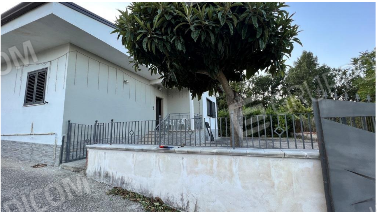
Foto 2 – Area di accesso all'abitazione delimitata da inferriata
