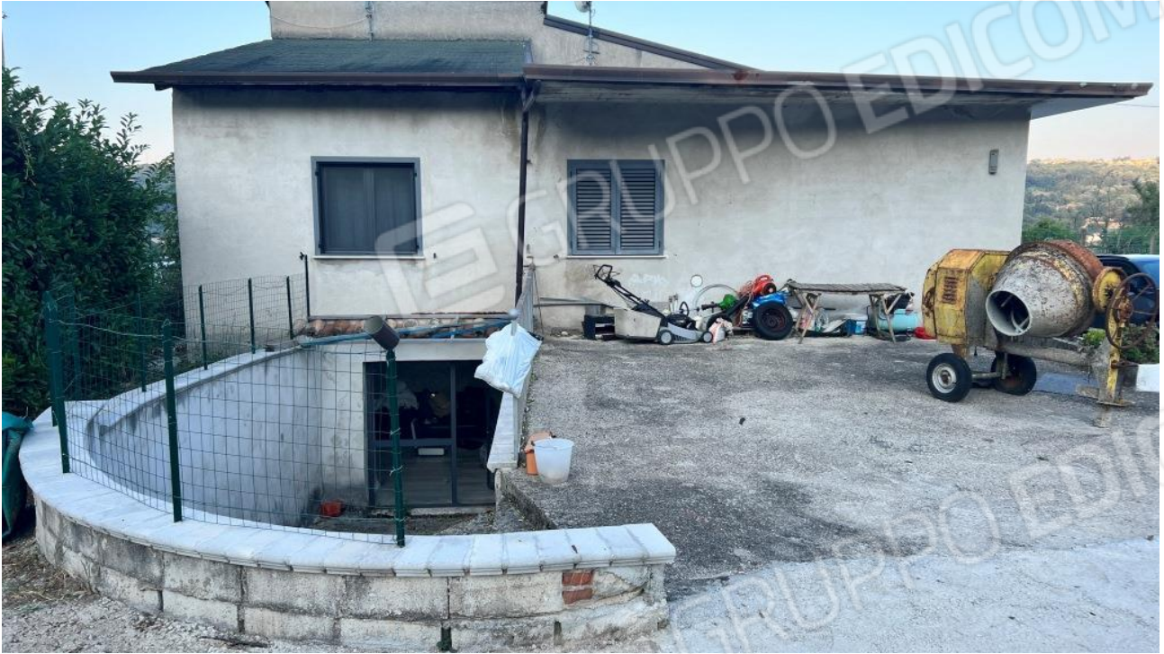
Foto 15 – Vista posteriore dell'abitazione lato OVEST
