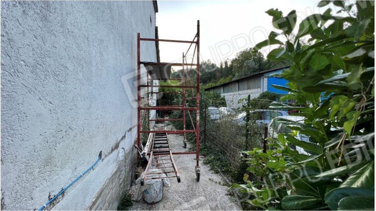
Foto 13 – Vista dell'abitazione lato NORD
