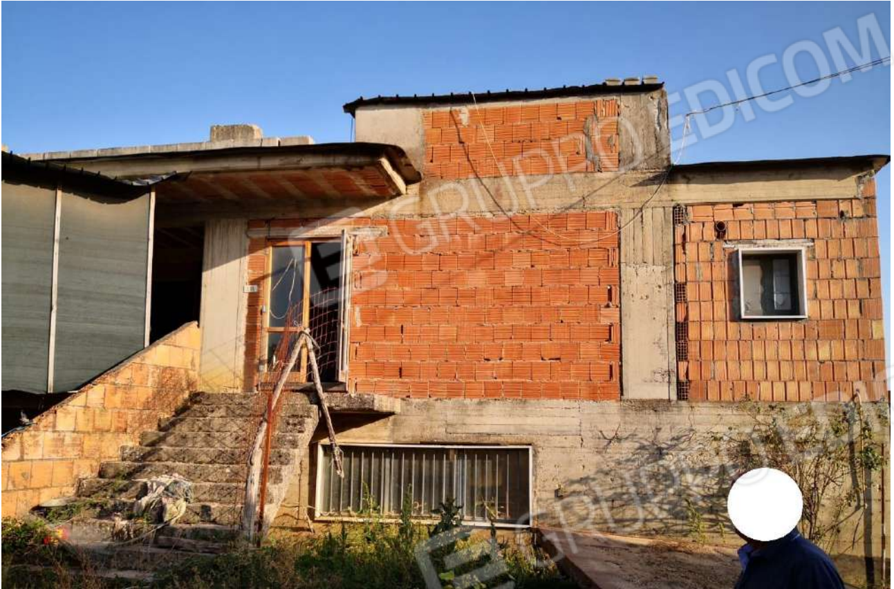
Fotogramma 16 - Fabbricato in corso di costruzione censito con il mappale 427 sub 2 e 3 – Vista esterna
