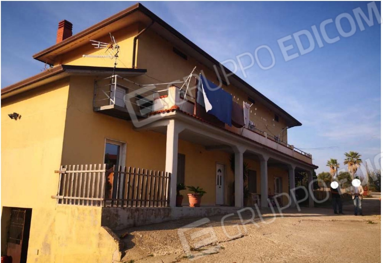
Fotogramma 05 – Fabbricato residenziale censito con il mappale 425
