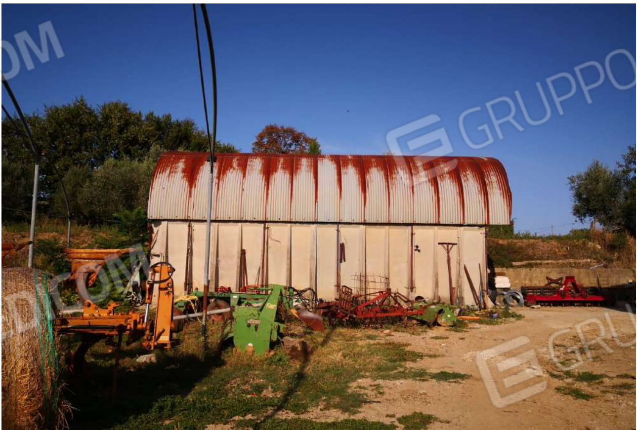
Fotogramma 48 – Deposito annesso alle costruzioni pertinenziali della p.Ila 576
