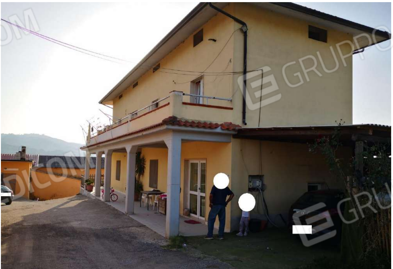
Fotogramma 04 – Fabbricato residenziale censito con il mappale 425
