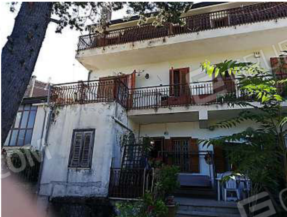
Foto 18: .. Terrazzino al Piano Rialzato – accesso all’area giardino ...
