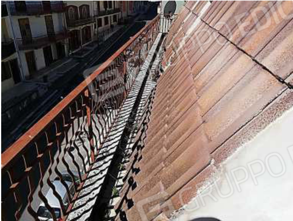
Foto 17: ..Balconi del Secondo Piano (Mansarda) ...
