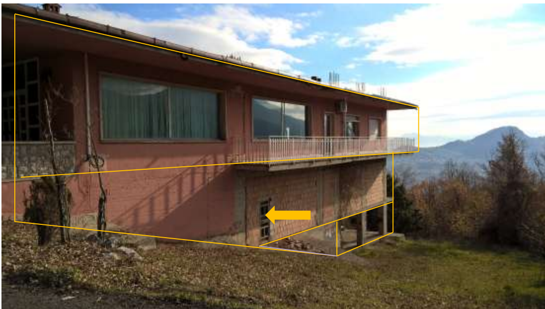
FOTO N. 10 NELLA FOTO SONO STATI EVIDENZIATI CON LA LINEA GIALLA I TRE LIVELLI DEL FABBRICATO OGGETTO DI AMPLIAMENTO MA NON DI PIGNORAMENTO:
