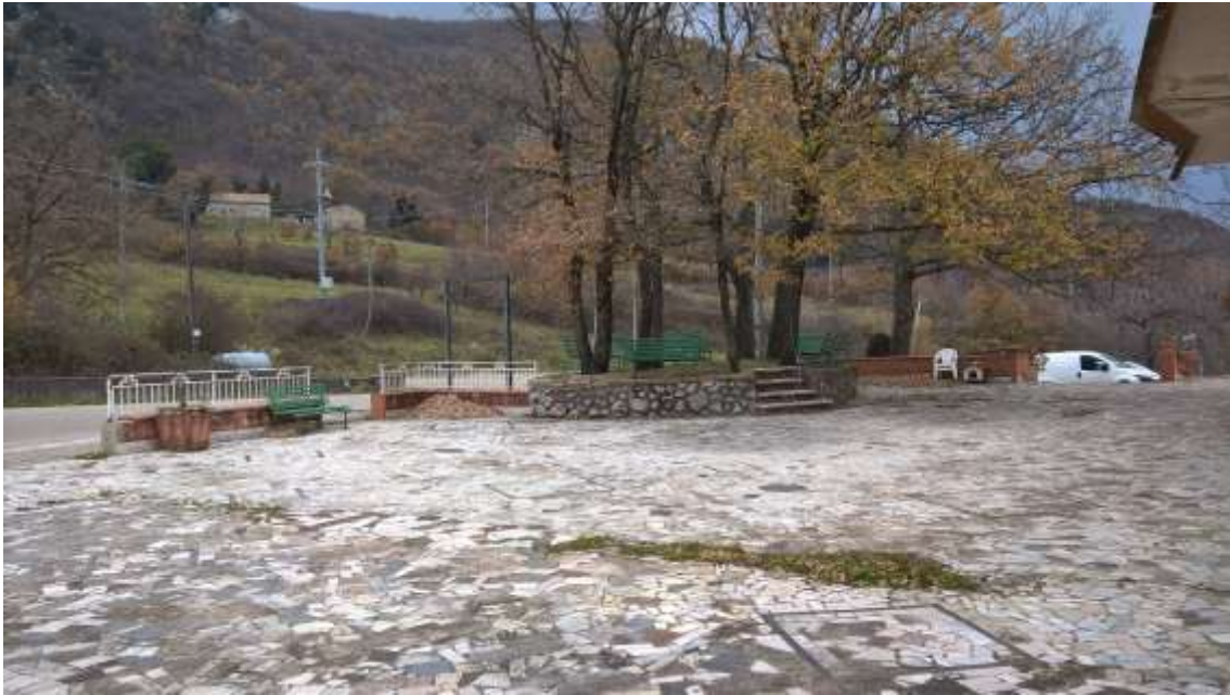
FOTO N. 13 AREA ESTERNA PERTINENZIALE
