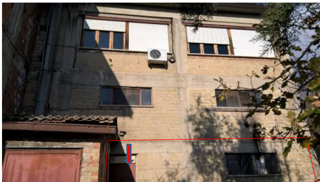
FOTO N. 6 2° LIVELLO SEMINTERRATO – DEPOSITO N. 1 VEDUTA ESTERNA
