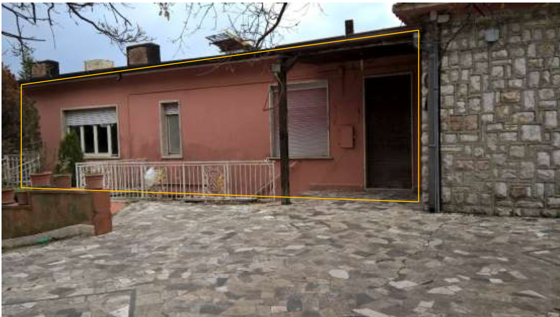
FOTO N. 8 PIANO TERRA CUCINA - NON PIGNORATA E NON CENSITA
