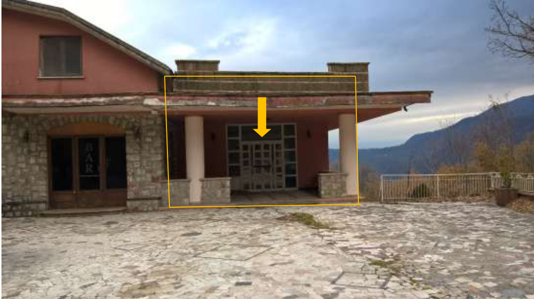
FOTO N. 9 PIANO TERRA SALA RISTORO - NON PIGNORATA E NON CENSITA
