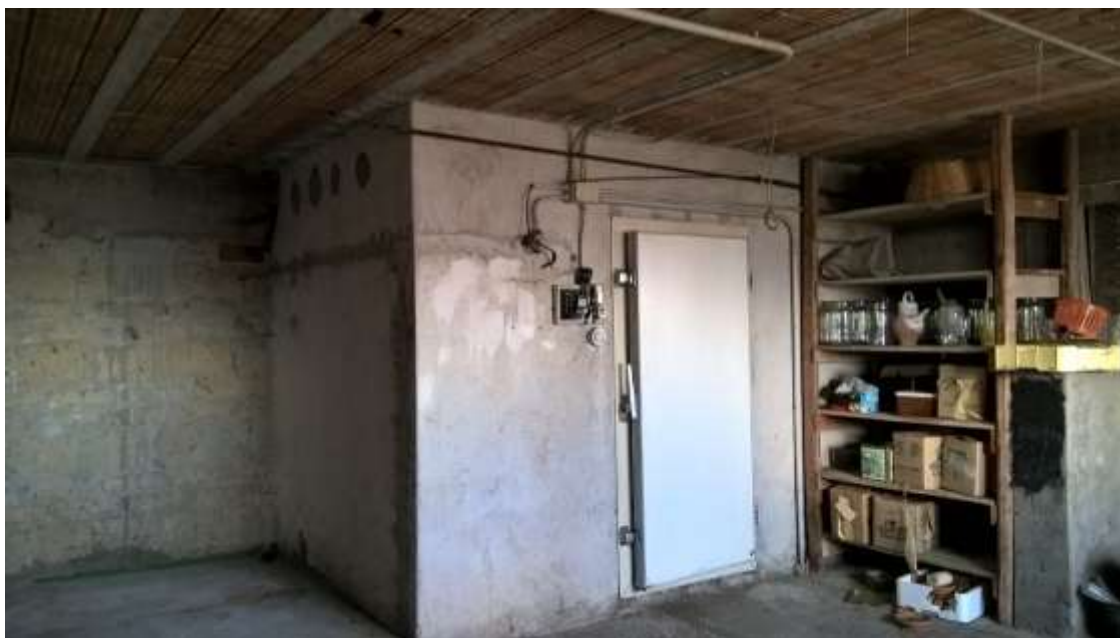
FOTO N. 5 1° LIVELLO SEMINTERRATO – DEPOSITO E CELLA FRIGO
