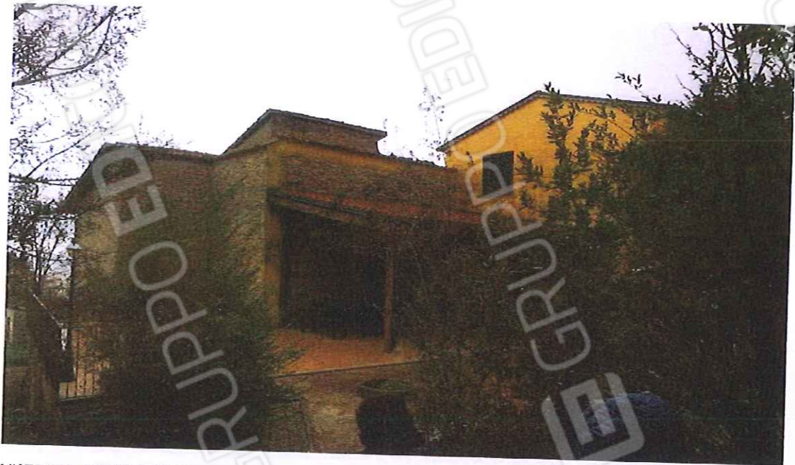
VISTA DEL PROSPETTO PRINCIPALE DELL'AGRITURISMO CON PORTICATO RICADENTE SU ALTRA DITTA
