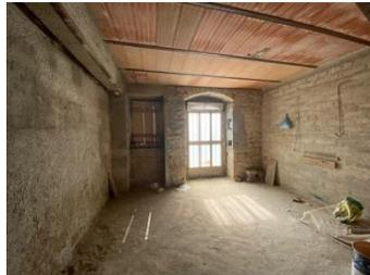
Solai - Strutture Orizzontali: Parte in latero-cemento (piano primo, secondo e sottotetto) e parte in ferro e laterizio ( piano terra solaio di separazione con il primo piano)
