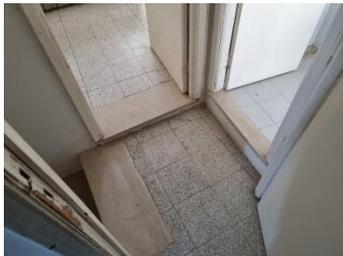
La pavimentazione è in graniglia di marmo, formato 20x20, posato a colla su massetto di sabbia e cemento, suggellatura dei giunti con fuga in cemento di colore grigio, spessore 0,5cm;
