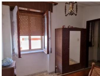
Infisso doppio in vetro camera con ante a battente e telaio in alluminio quello esterno ed in legno quello interno con veto singolo;
