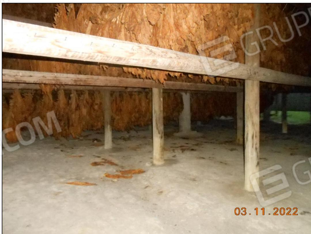
**FOTO N. 52 Particolare dei pali cementati alla base. Capanna adibita a stenditoio per il tabacco, fg. 3 p.la 435/8.**
