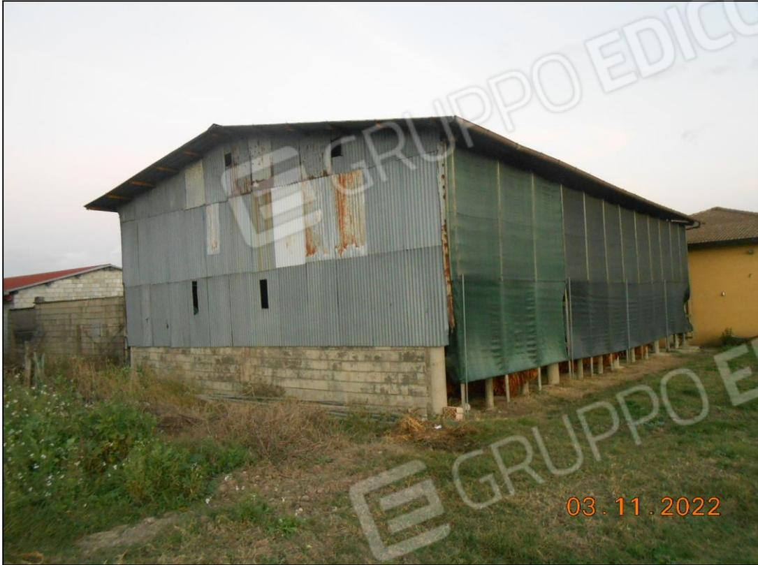
**FOTO N. 47** Vista della capanna in lamiera, adibita a stenditoio per il tabacco, fg. 3 p.lla 435/8.
