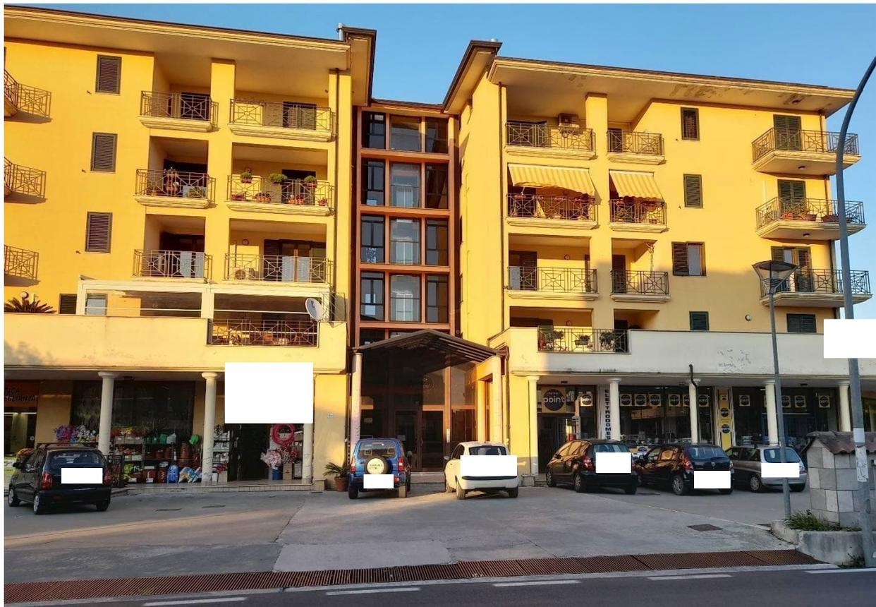
L'androne è ampio ed è costituito da una struttura di copertura in vetro e travi di alluminio.
