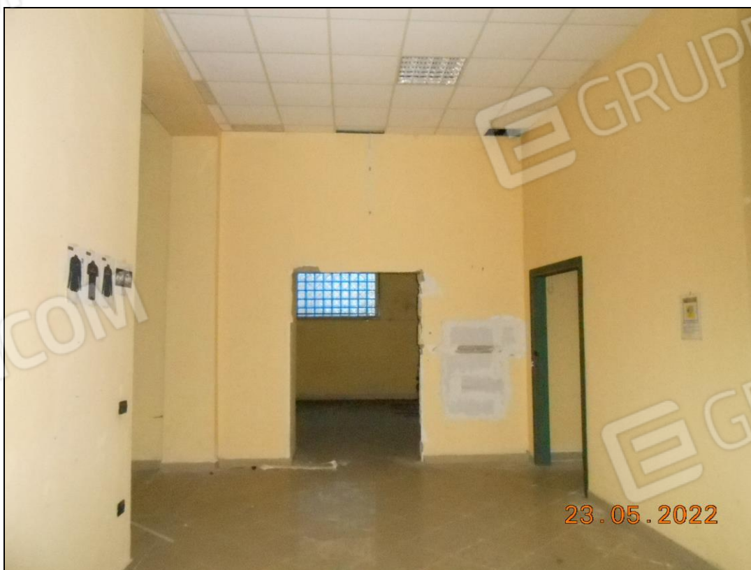
FOTO N. 18 Vista interna dei locali dell'immobile.
