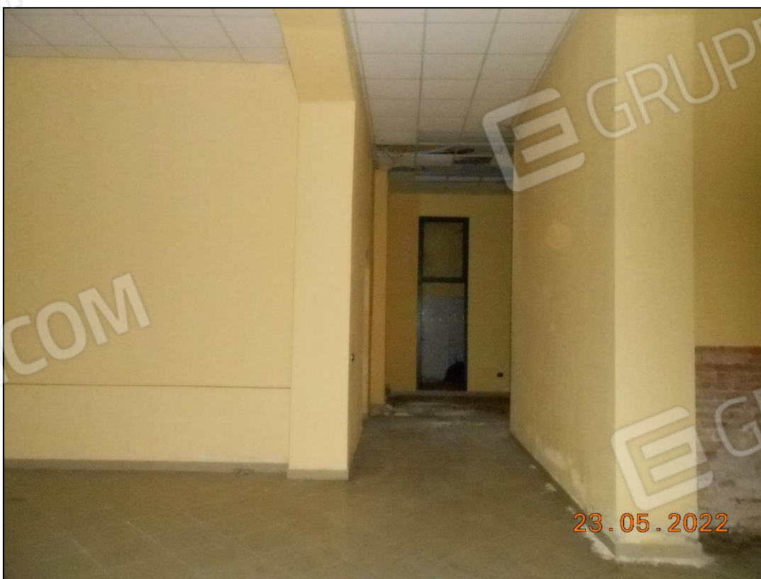
FOTO N. 14 Vista interna dei locali posteriori dell'immobile.
