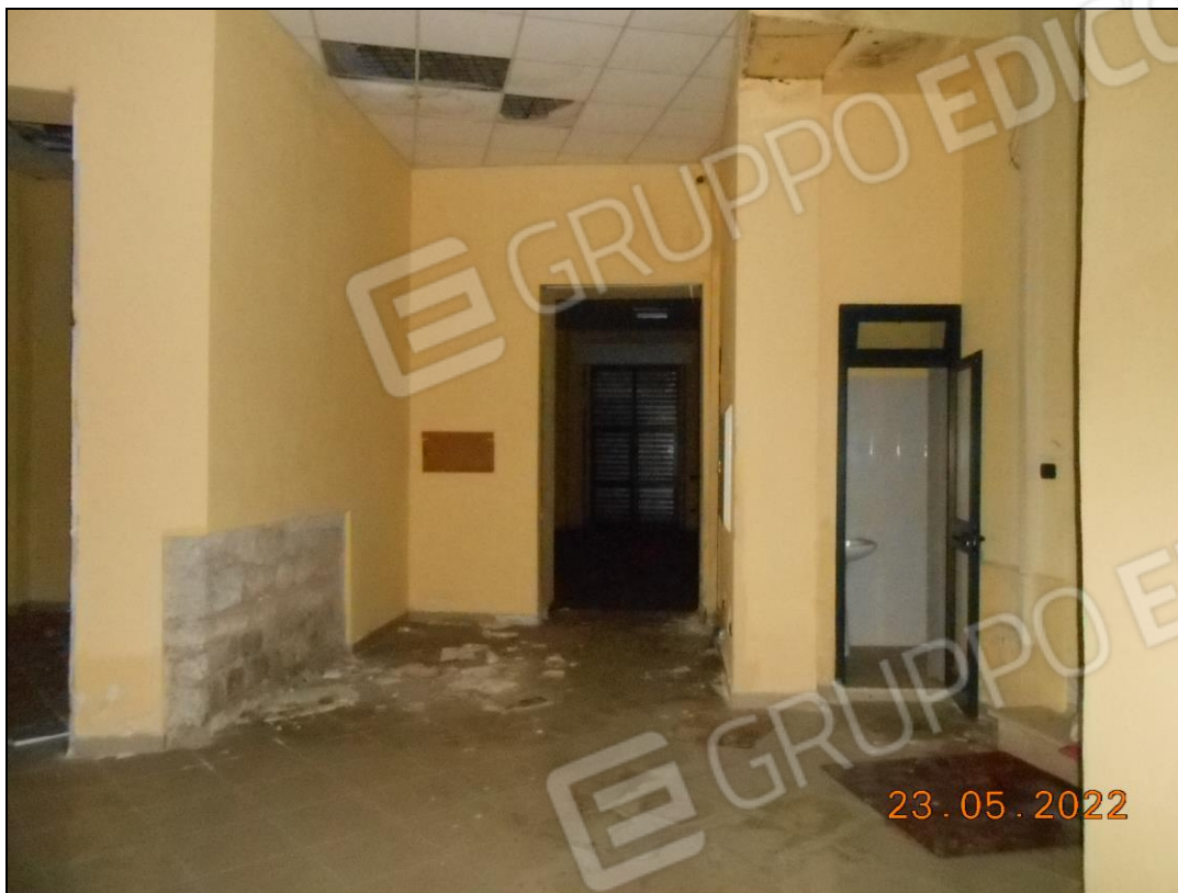
FOTO N. 35 Vista interna dei locali dell'immobile.
