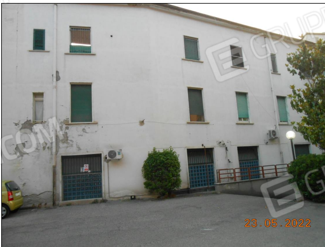
FOTO N. 52 Vista posteriore del fabbricato.
