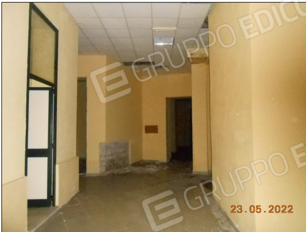
FOTO N. 31 Vista interna dei locali dell'immobile.
