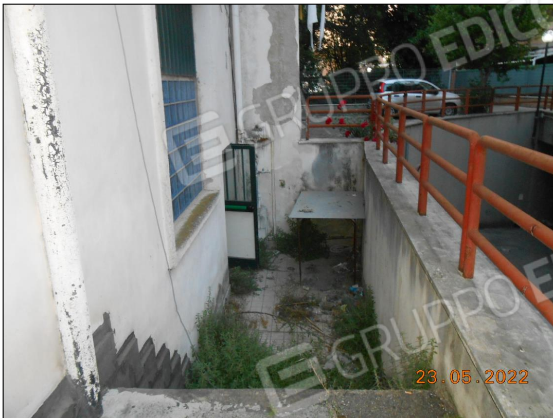
FOTO N. 51 Vista porta di accesso alla corte comune p.lla 316.
