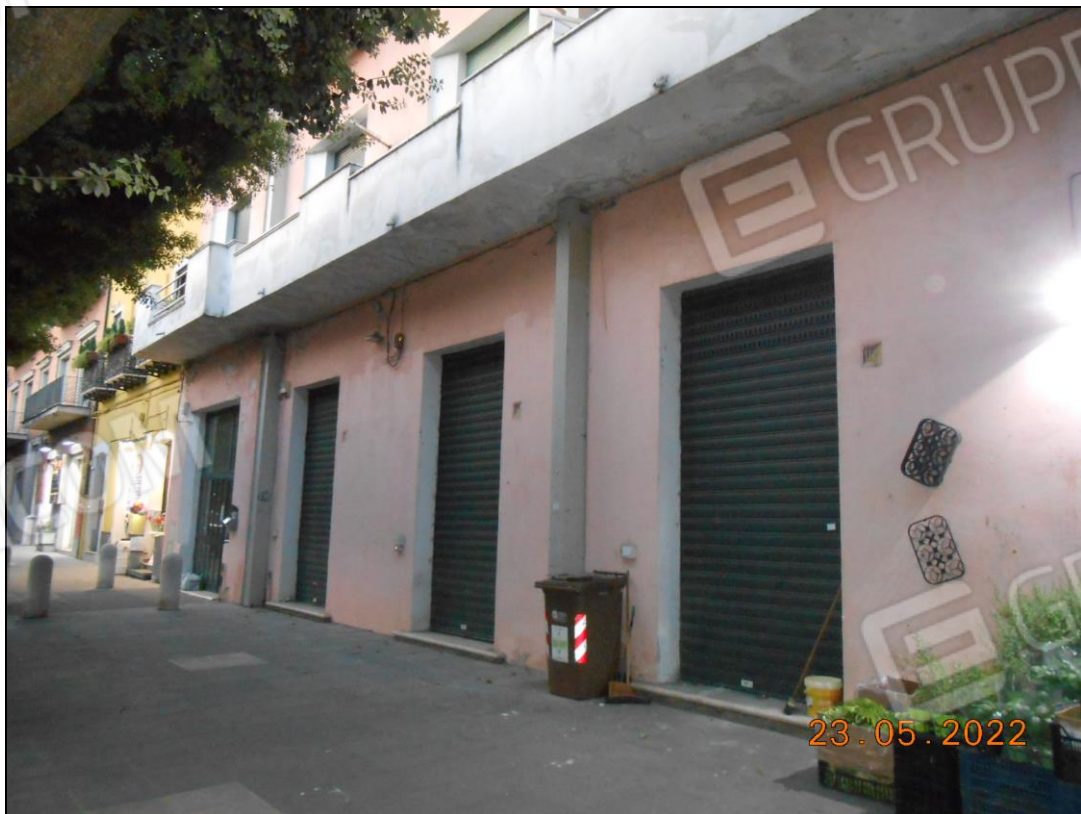
FOTO N. 06 Vista dell'immobile pignorato a piano terra del fabbricato.
