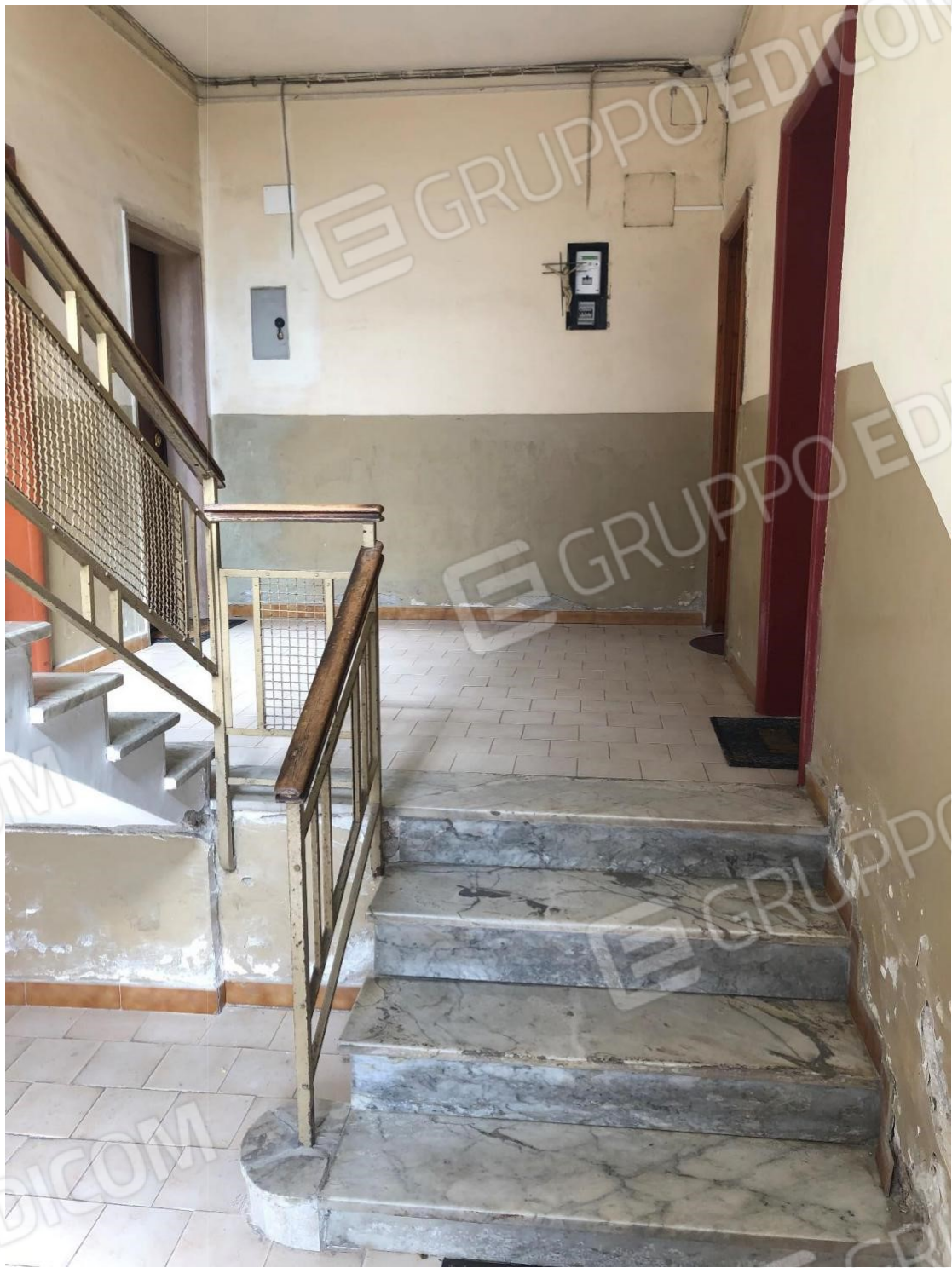
Foto n.6: Foto dell'ingresso alle scale dell'appartamento in Via Cesare Battisti n. 6 a Benevento NCEU al foglio 93 particella 102 sub 11.
