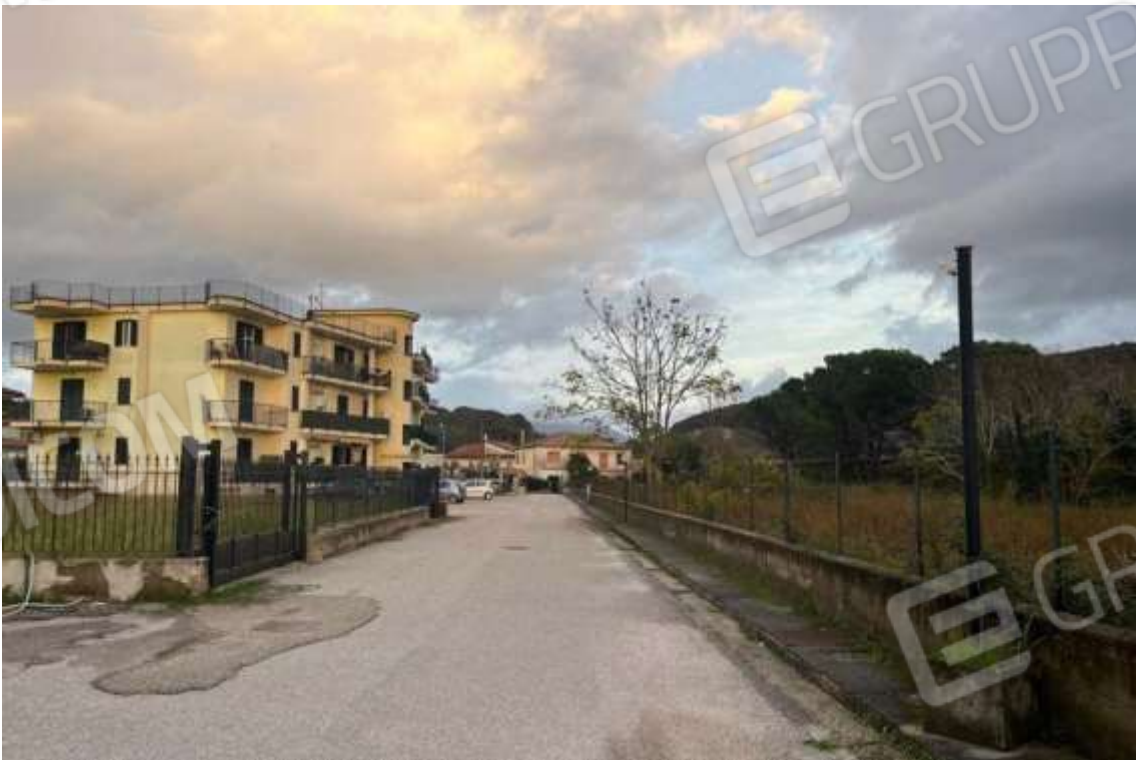
Fig.2 – Vista del l'accesso al Fabbricato da via Bagni/SP46
