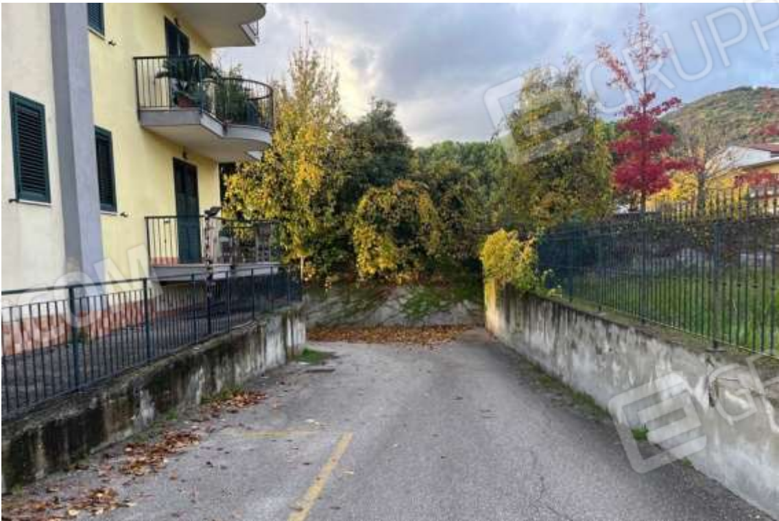
Fig.2 – Vista dell'accesso alla zona box
