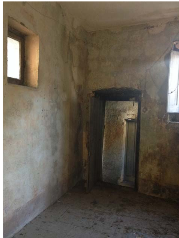
11) VISTA INTERNA VANO (P. 1 – SUB 25)
