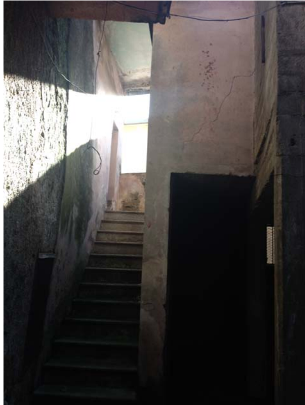
10) SCALA DI ACCESSO AL SUB 25 - PIANO PRIMO
