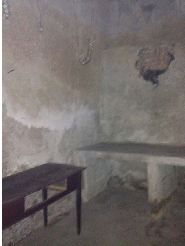
8) FOTO INTERNA DEL VANO IDENTIFICATO COME CUCINA (P. T. – SUB 25)
