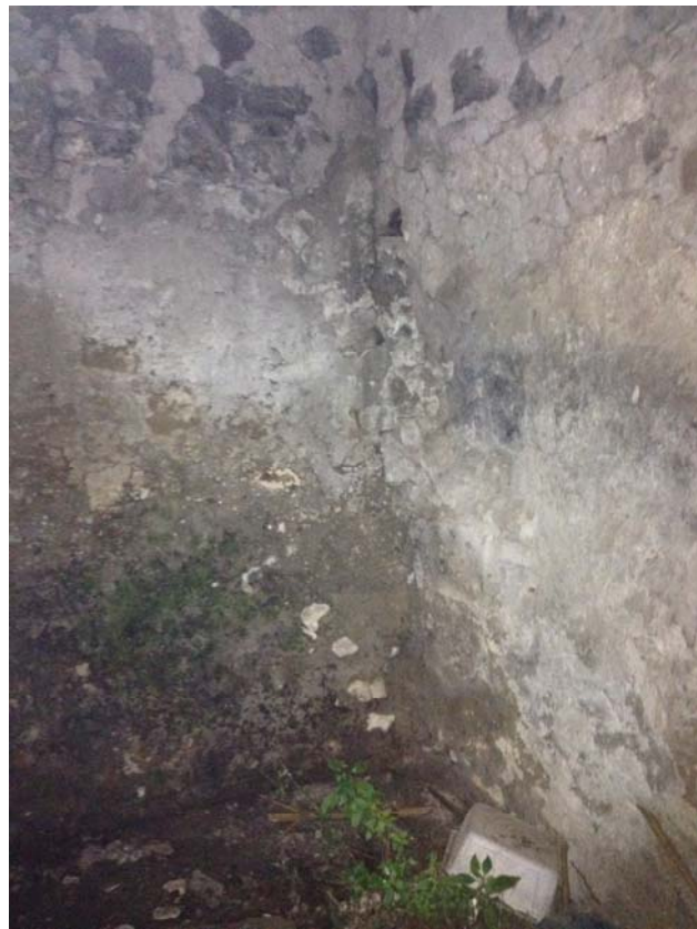
9) VEDUTA INTERNA DEL VANO STALLA (P. T. .. SUB 24)
