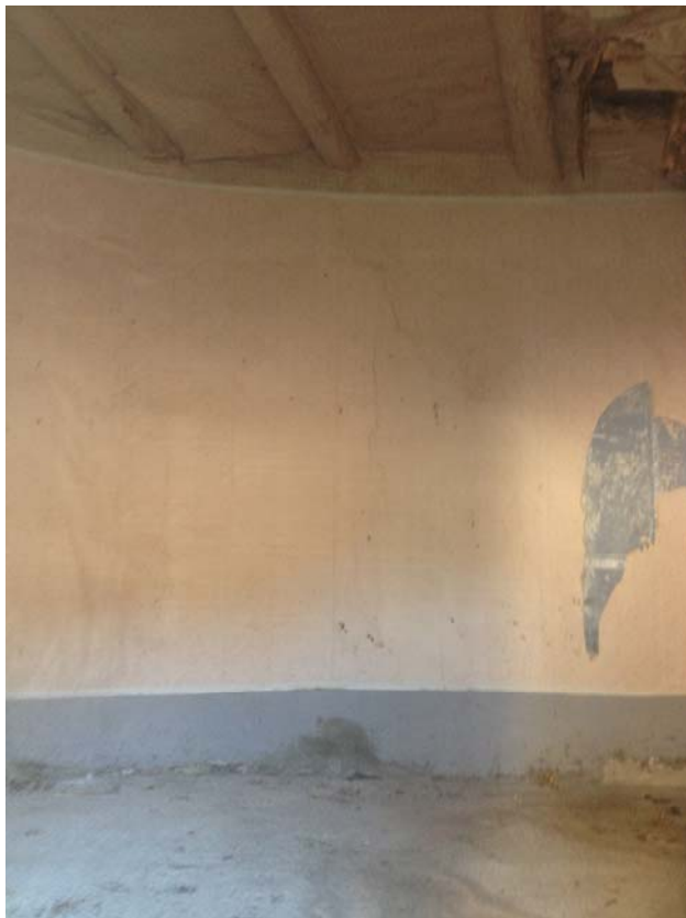
17) VEDUTA INTERNA CON PARTICOLARE DEL SOLAIO IN LEGNO (SUB 26)
