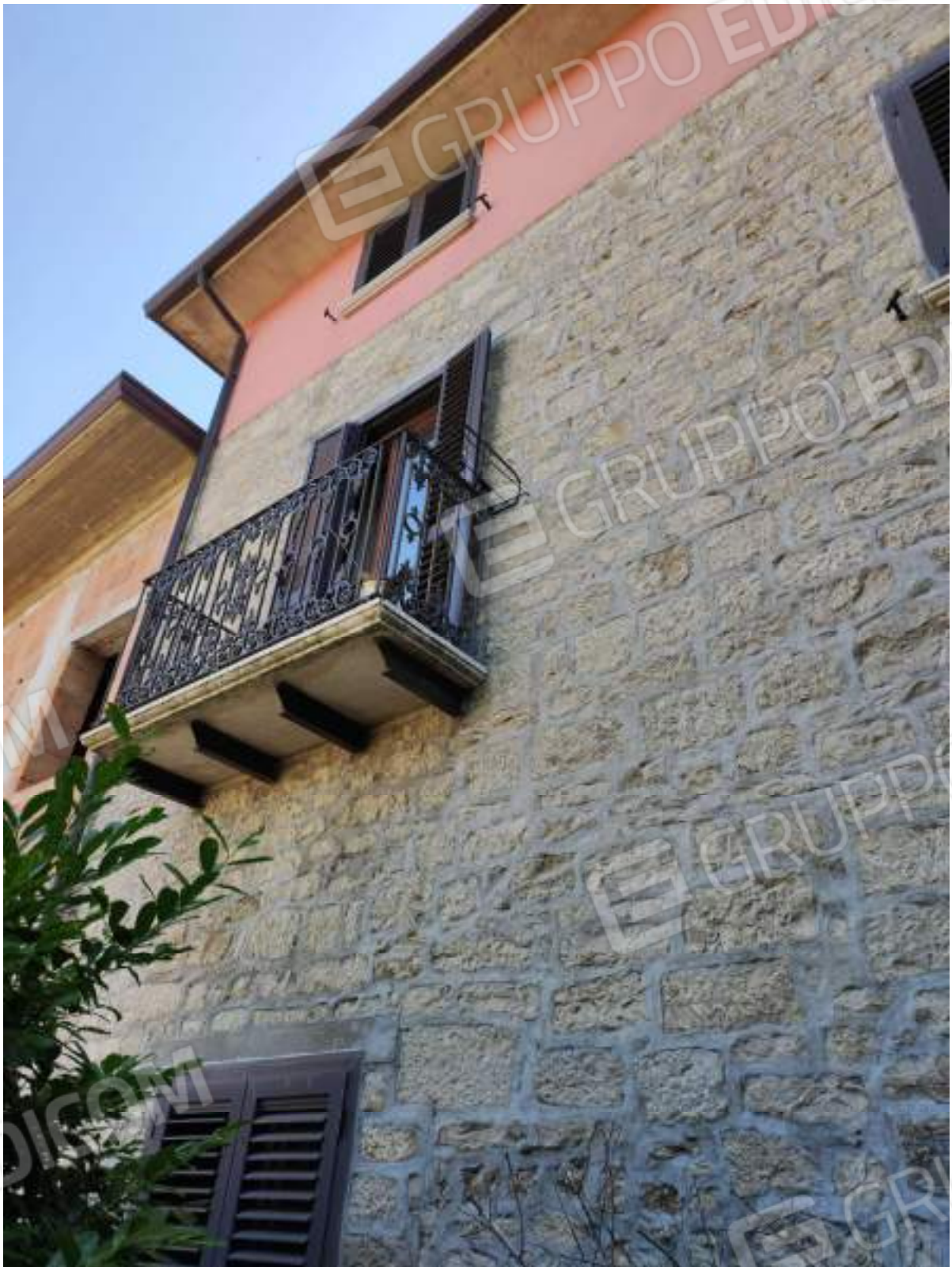
Foto 7 Vista laterale dell'immobile
