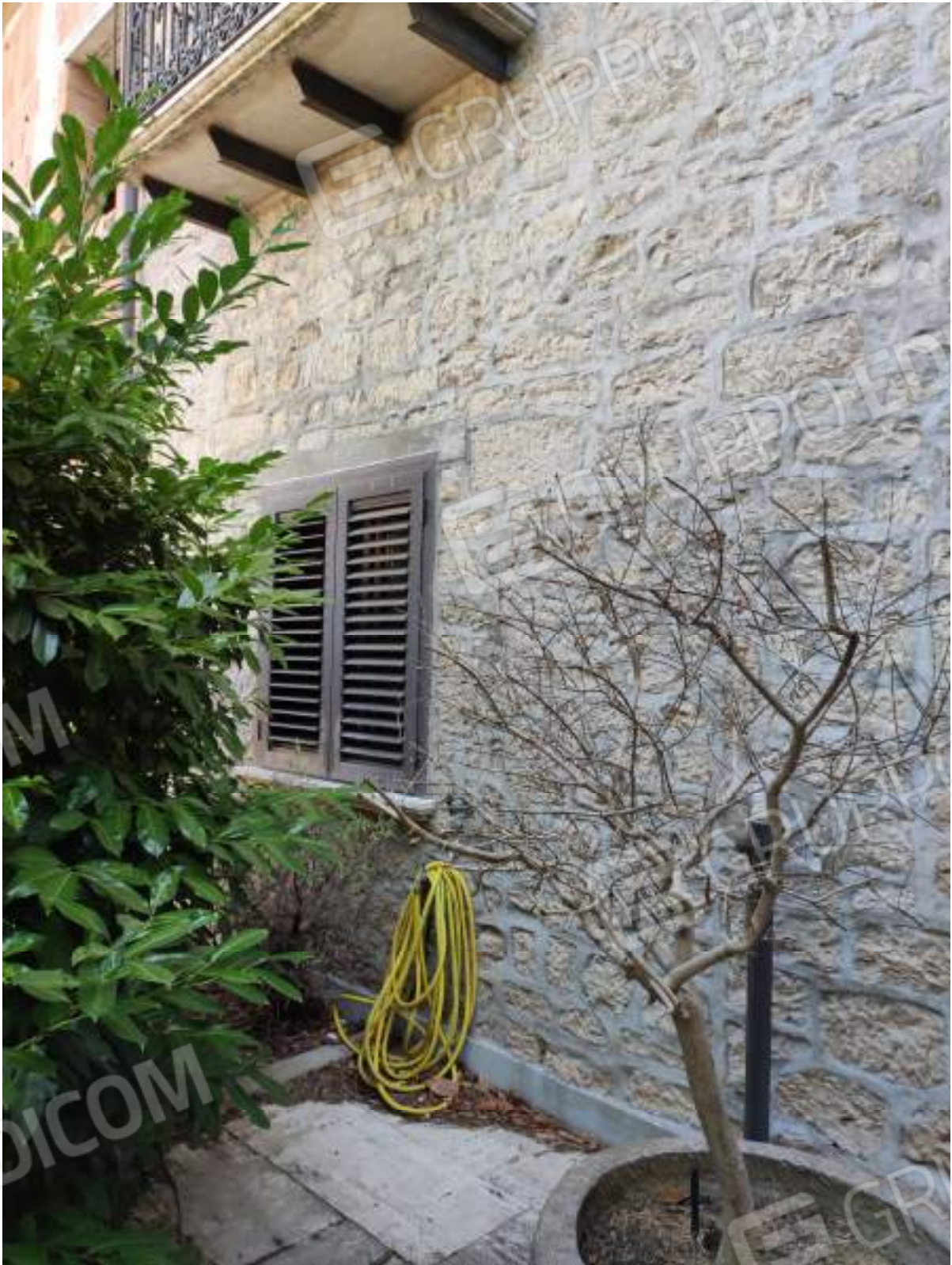
Foto 6 Finestra del Locale seminterrato
