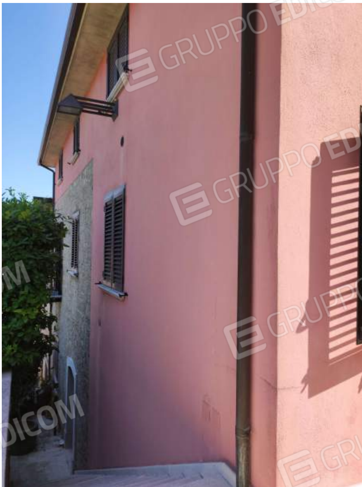
Foto 4 Esterno abitazione con accesso al locale seminterrato
