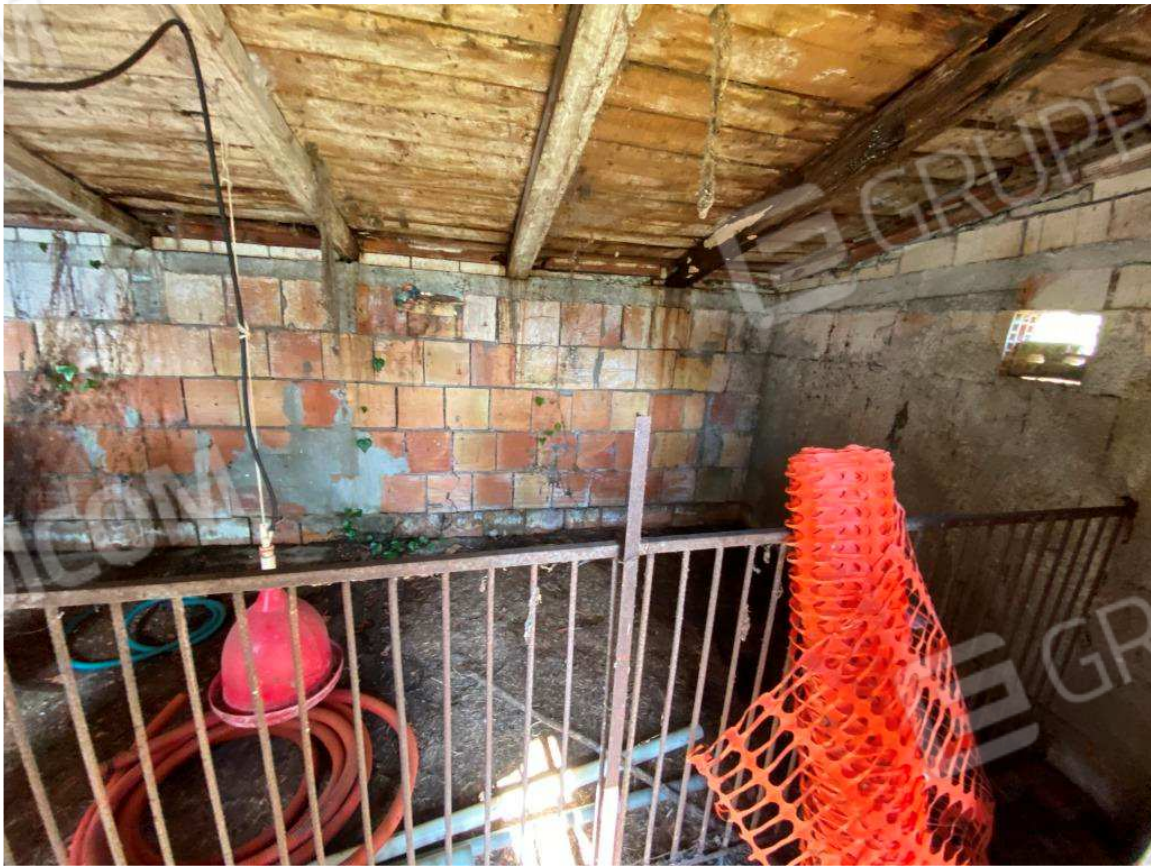
Foto 6 – Interno del manufatto
