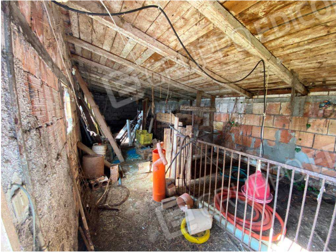
Foto 5 – Interno del manufatto
