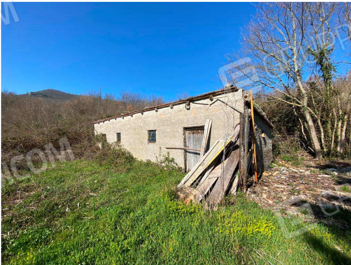
Foto 4 – Vista lato SUD del manufatto ad uso stalla sulla particella 631
