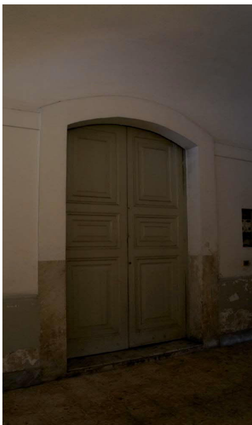
FOTO 5: Ingresso deposito sub.22 dall'androne.
