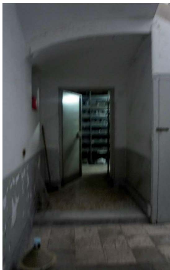
FOTO 6: Ingresso deposito sub.21 dall'androne.
