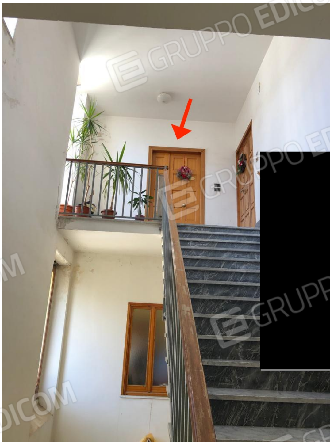
Foto n.9: Foto delle scale dal pianerottolo del piano 1° in evidenza la porta di ingresso dell' appartamento di nostro interesse NCEU al foglio 15 particella 697 sub 12.
