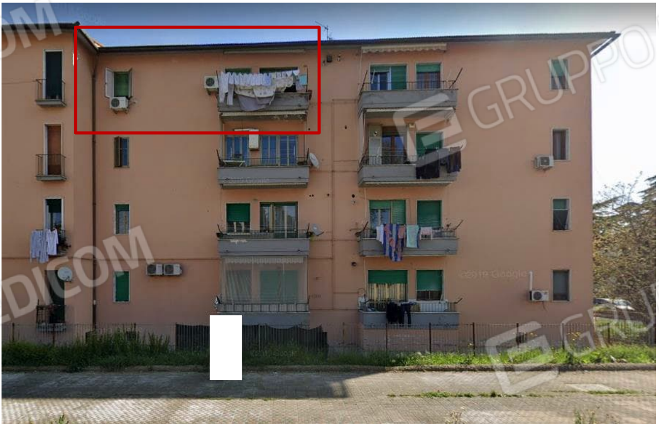
FOTO 4_ Fronte su via C.B. Conte di Cavour
