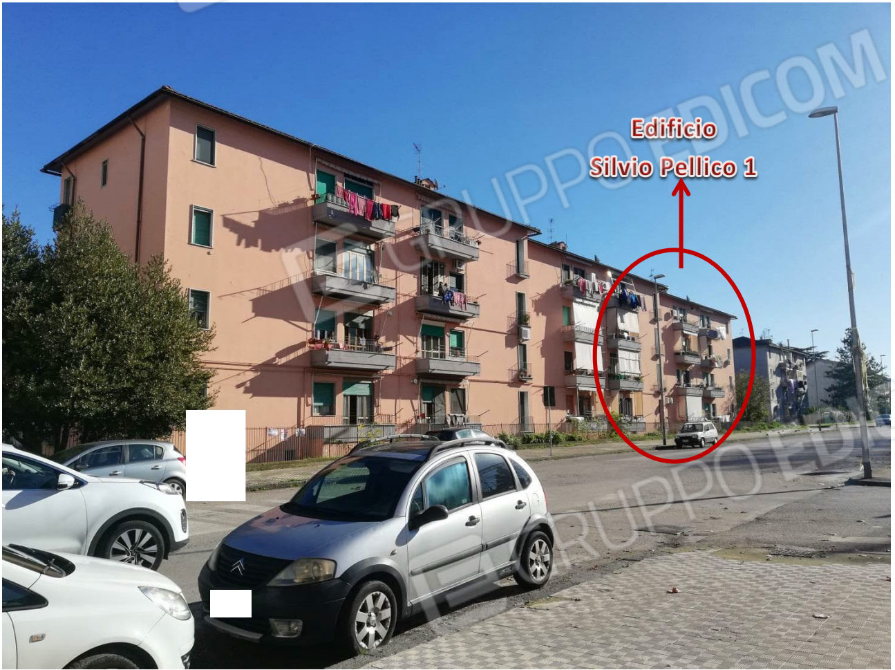
FOTO 3 _Vista da via C.B. Conte di Cavour
