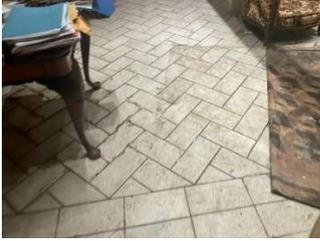
Nella zona abitativa: pavimento in ceramica formato cm. 30x30 Nei locali di sgombero: graniglia 20x20, posato a colla su massetto di sabbia e cemento suggellatura dei giunti con fuga in cemento di colore grigio, spessore cm. 0,5; nella cantina: pavimento in cotto;
