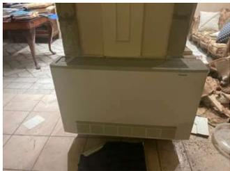
Impianto termico: presenti termoconvettori – impianto non funzionante
