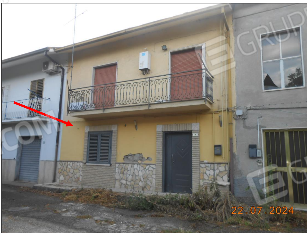
FOTO N. 02 Vista della porzione dell'immobile pignorato a P.T..
