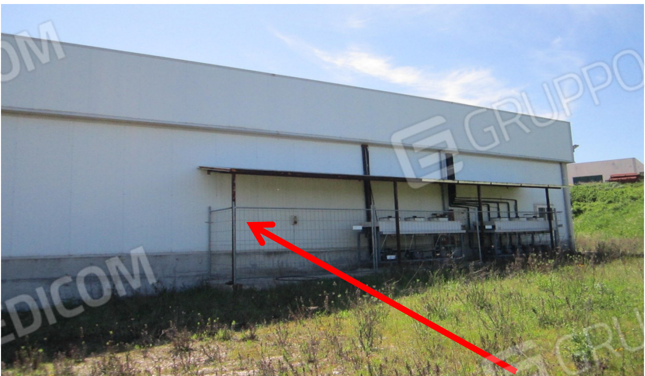
Tettoia realizzata in profilati in ferro e copertura in lamiera per ricovero Compressori in assenza di autorizzazione
