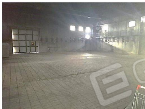
foto 19: ... ex Sala lavorazione
