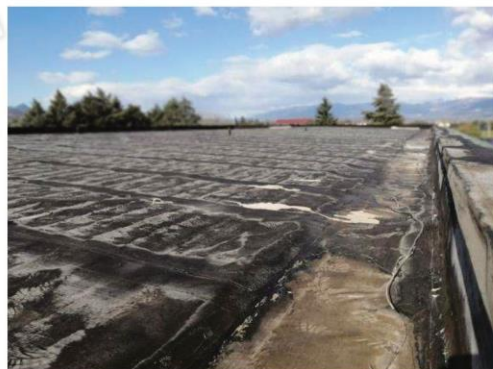
foto 53: ... stato della copertura
