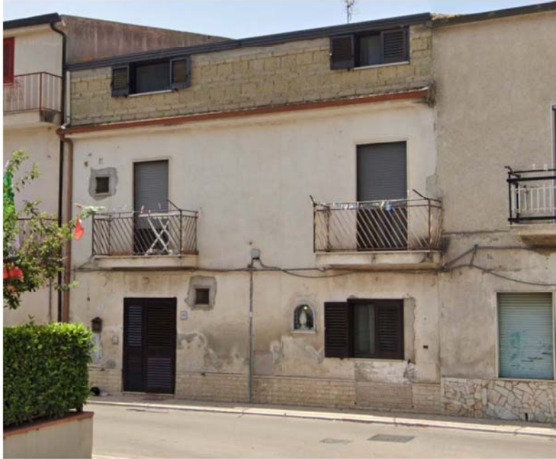
FOTO DEL PROSPETTO PRINCIPALE SULLA VIA SANNITA
