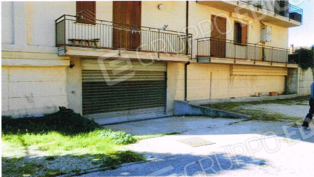
FOTO DELLA DELL'INGRESSO AL PIANO SEMINTERRATO
