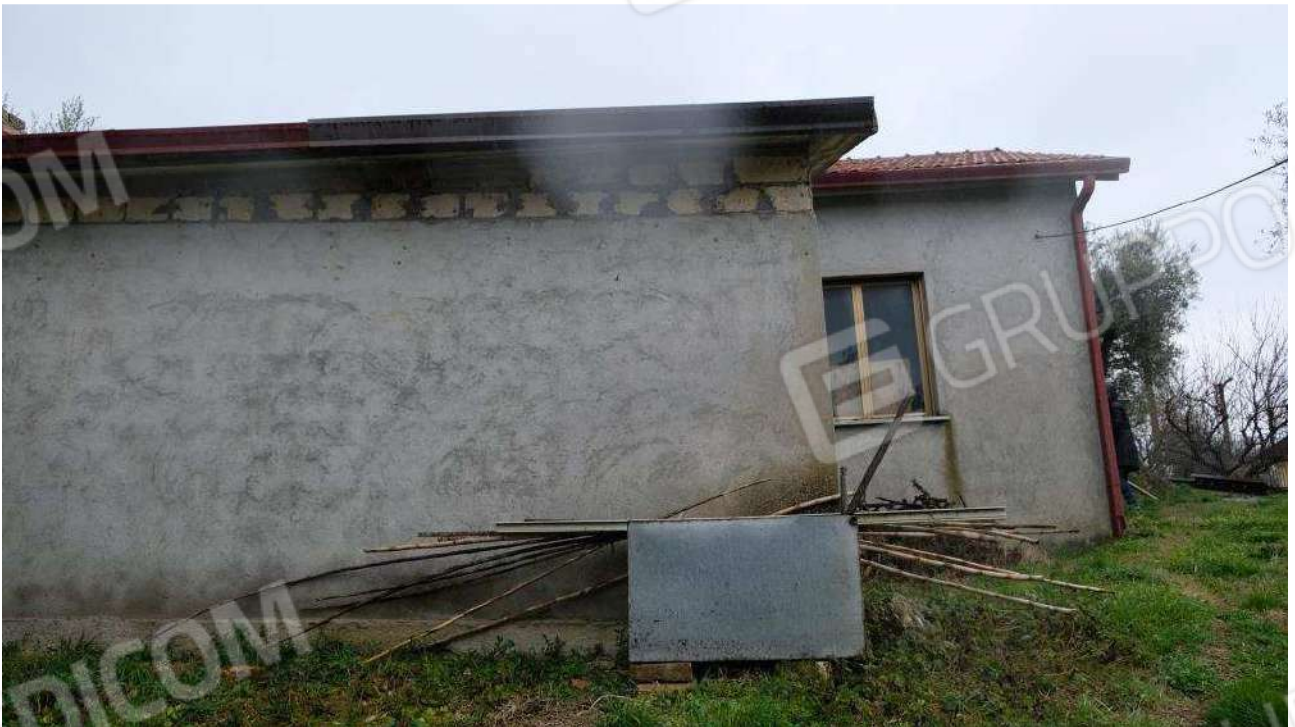
Foto 16 – Vista dell'autorimessa lato OVEST
