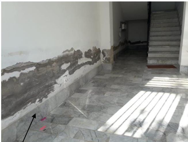
qui sotto messa in evidenza wc con fenomeno infiltrativo verosimilmente proveniente da wc dell'appartamento
