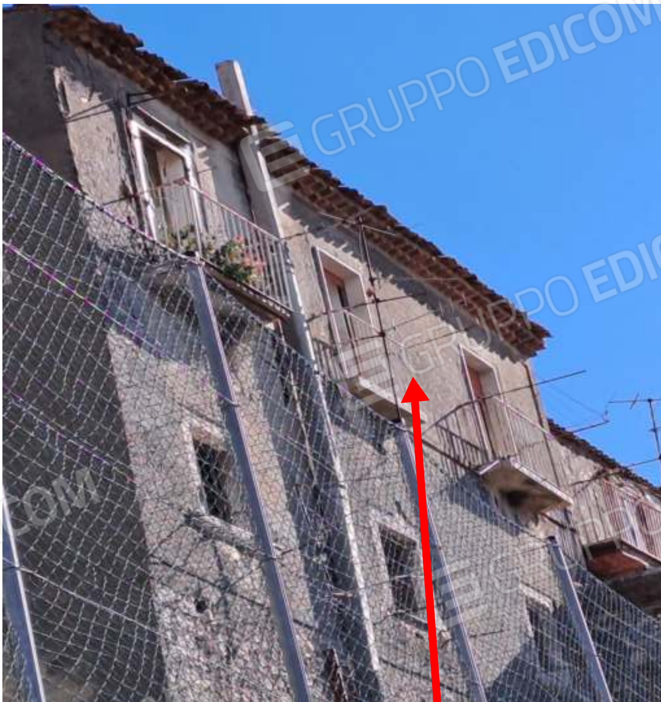
FOTO N. 15 VISTA DEL PROSPETTO ESTERNO DAL LATO SUD OVEST DEL CESPITE
