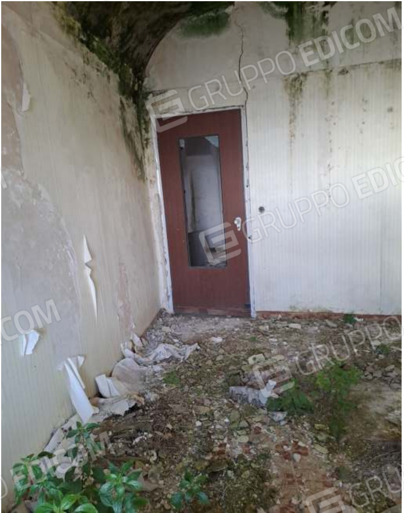
FOTO N. 6 ALTRA VISTA DEL LOCALE LETTO 2
