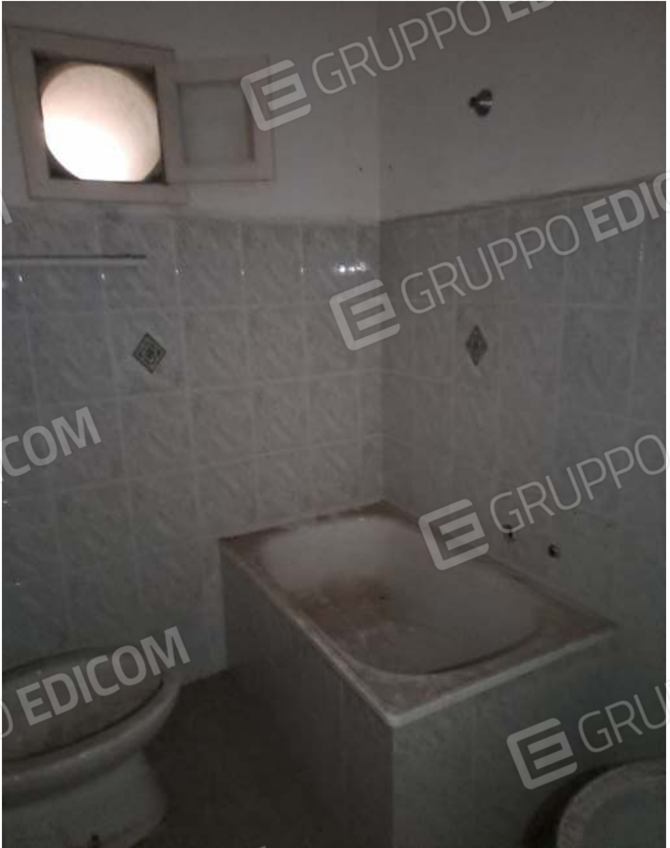
FOTO N. 10 VISTA DEL LOCALE BAGNO
