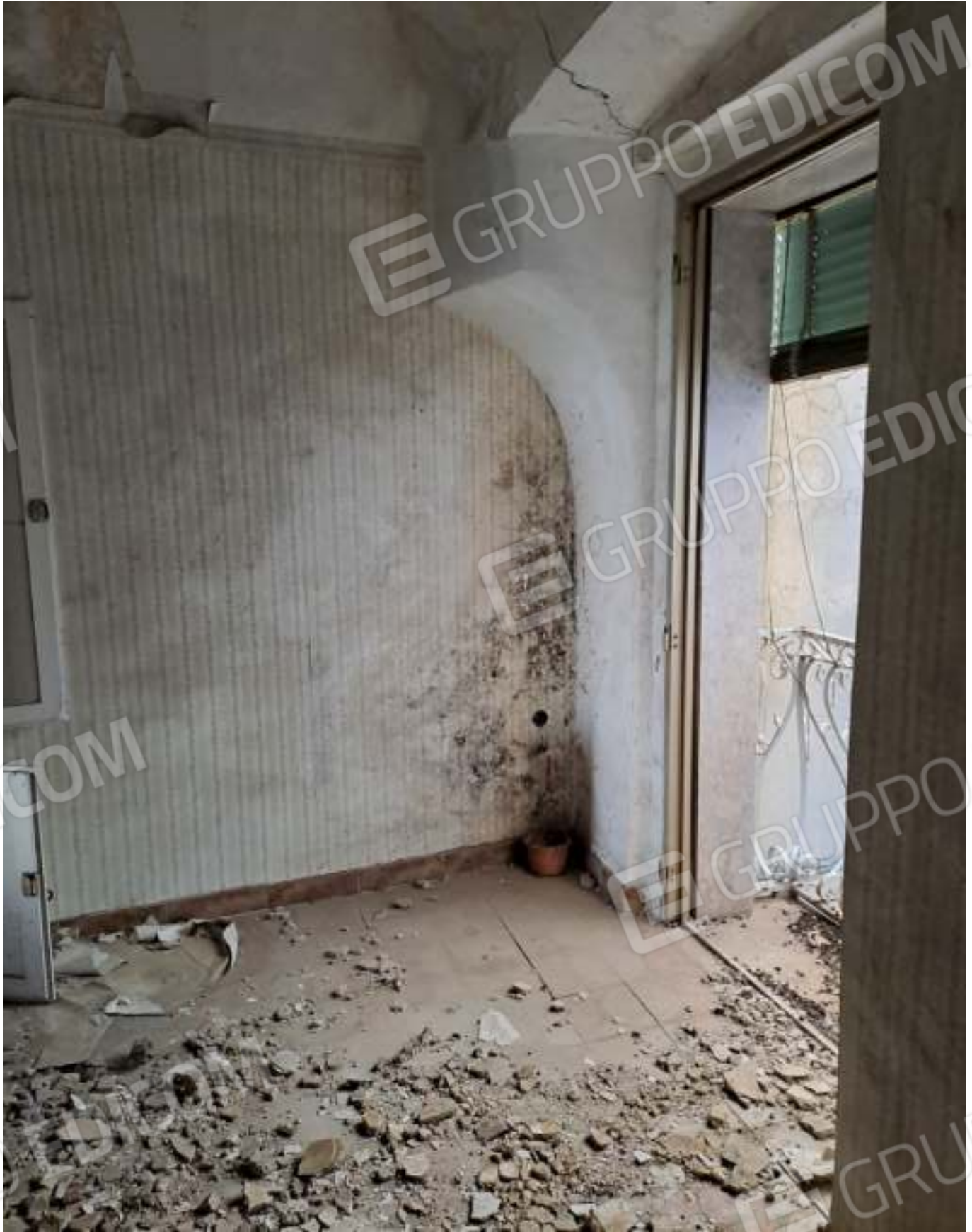
FOTO N. 5 ALTRA VISTA DEL LOCALE LETTO 1
