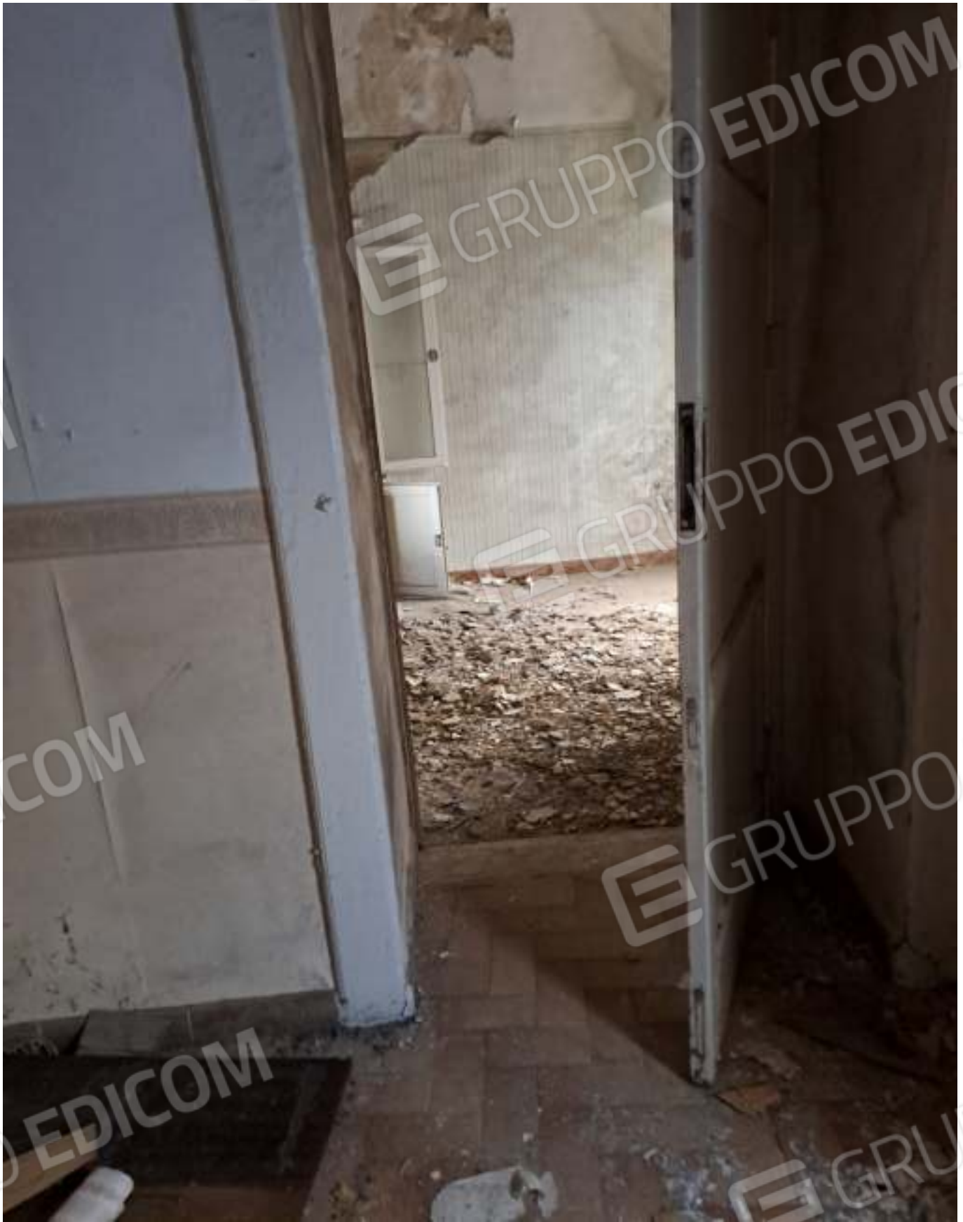
FOTO N. 4 VISTA DEL LOCALE LETTO 1
