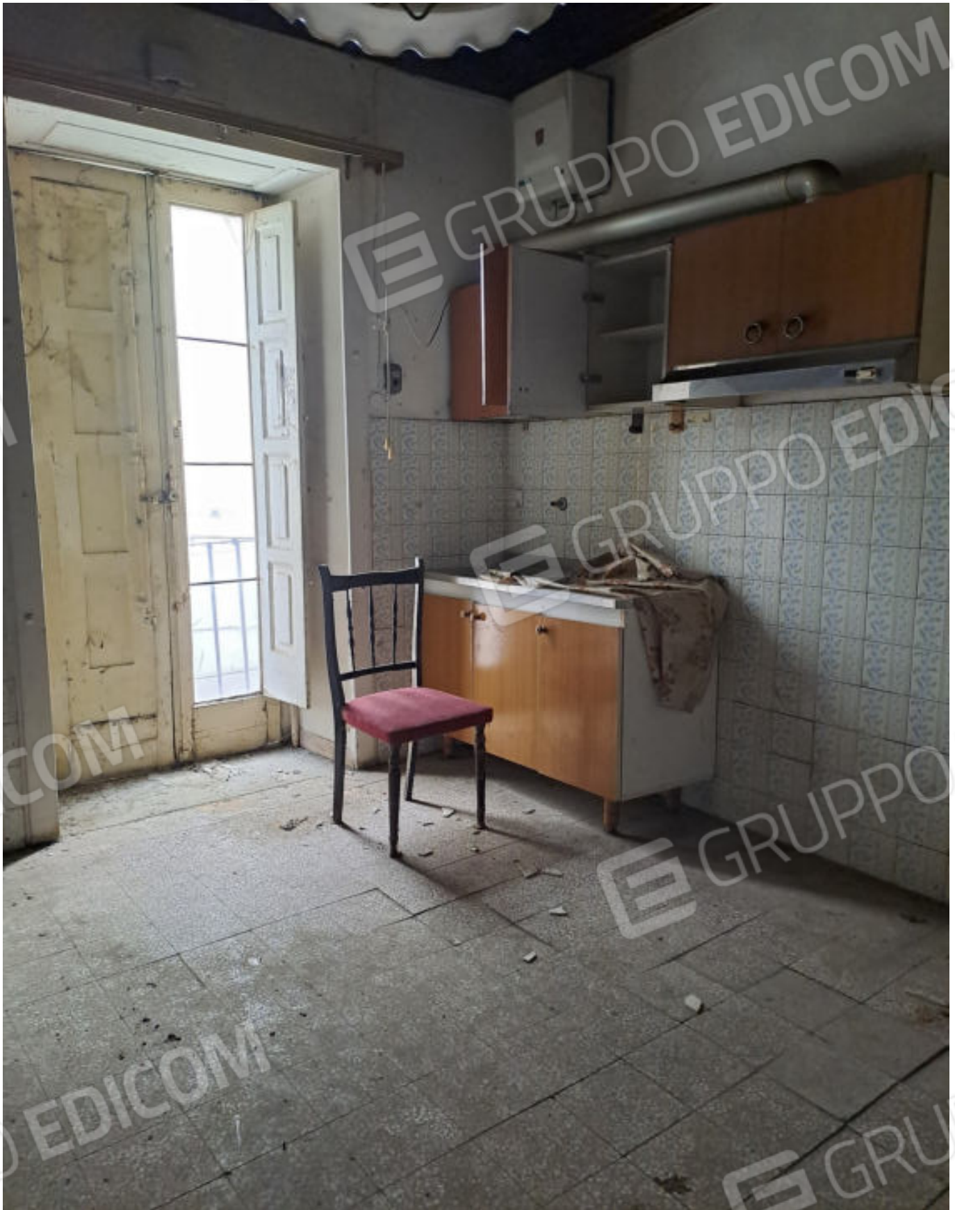
FOTO N. 6 VISTA DEL LOCALE CUCINA
