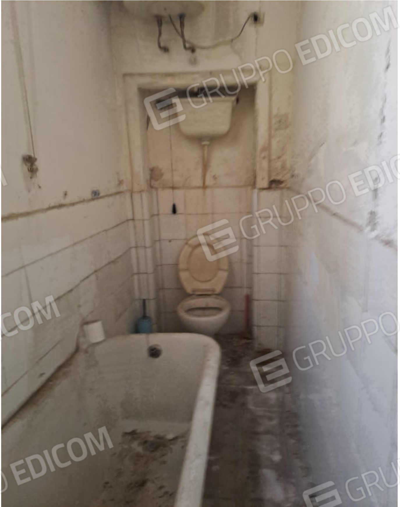
FOTO N. 7 VISTA DEL LOCALE BAGNO DEL PIANO PRIMO
