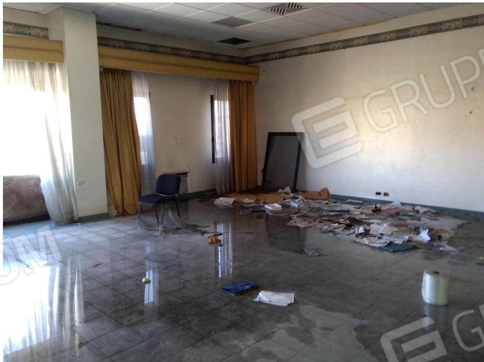
VANO OPIFICIO –PIANO PRIMO
