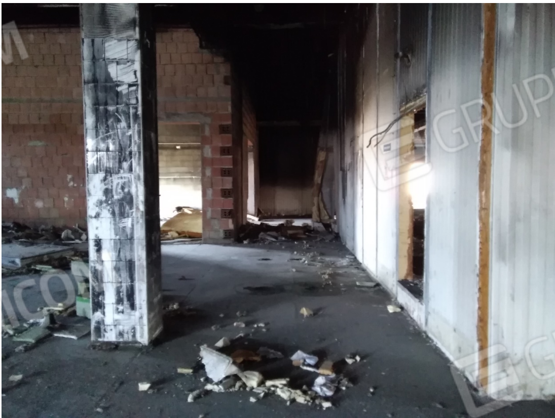
INTERNO OPIFICIO – PIANO TERRA
