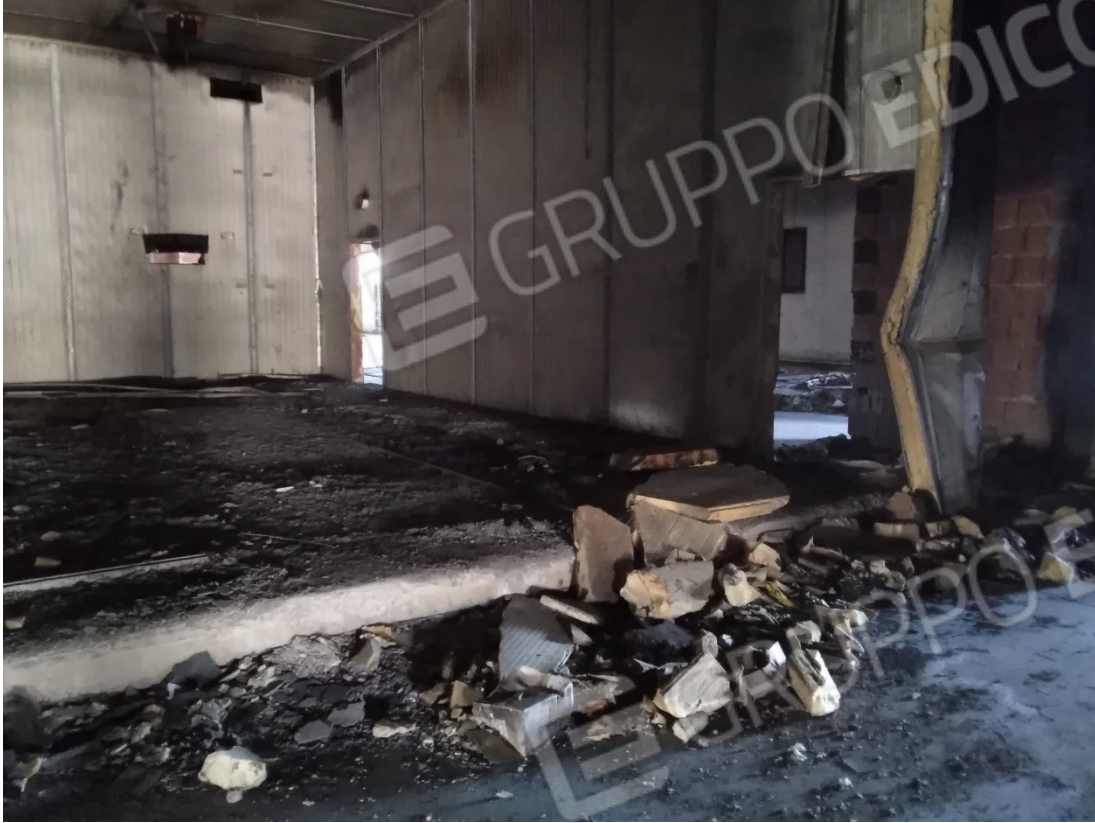
INTERNO OPIFICIO – PIANO TERRA
