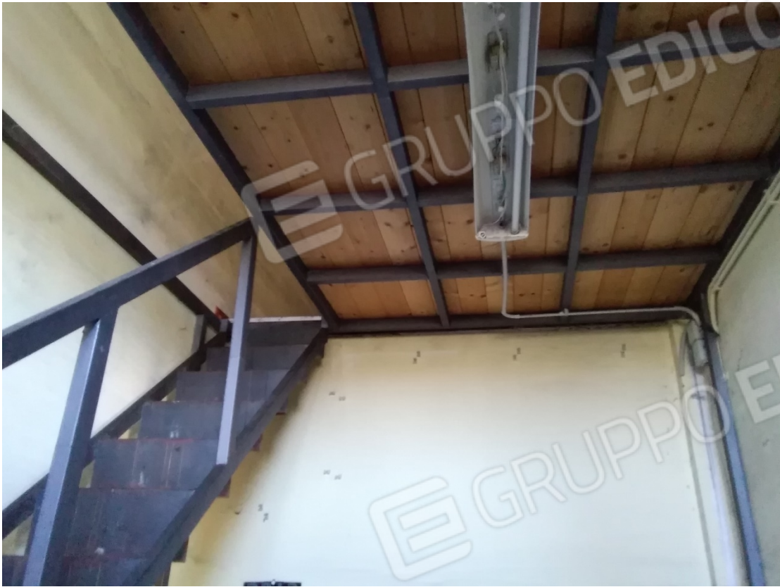
SCALA DI COLLEGAMENTO AL SOPPALCO
