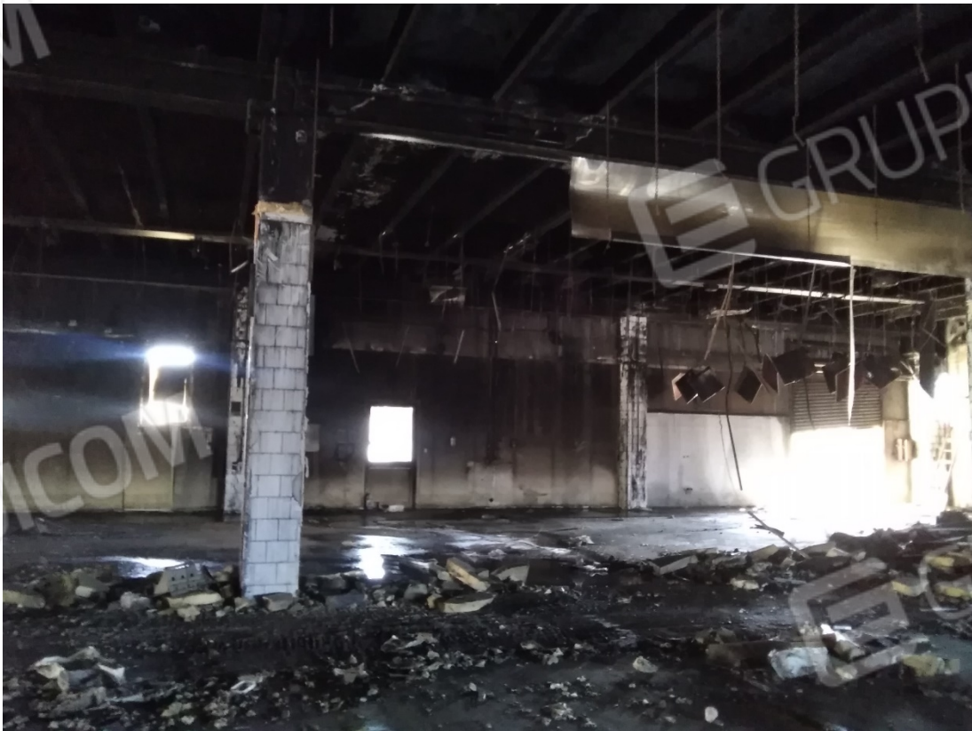
INTERNO OPIFICIO – PIANO TERRA
