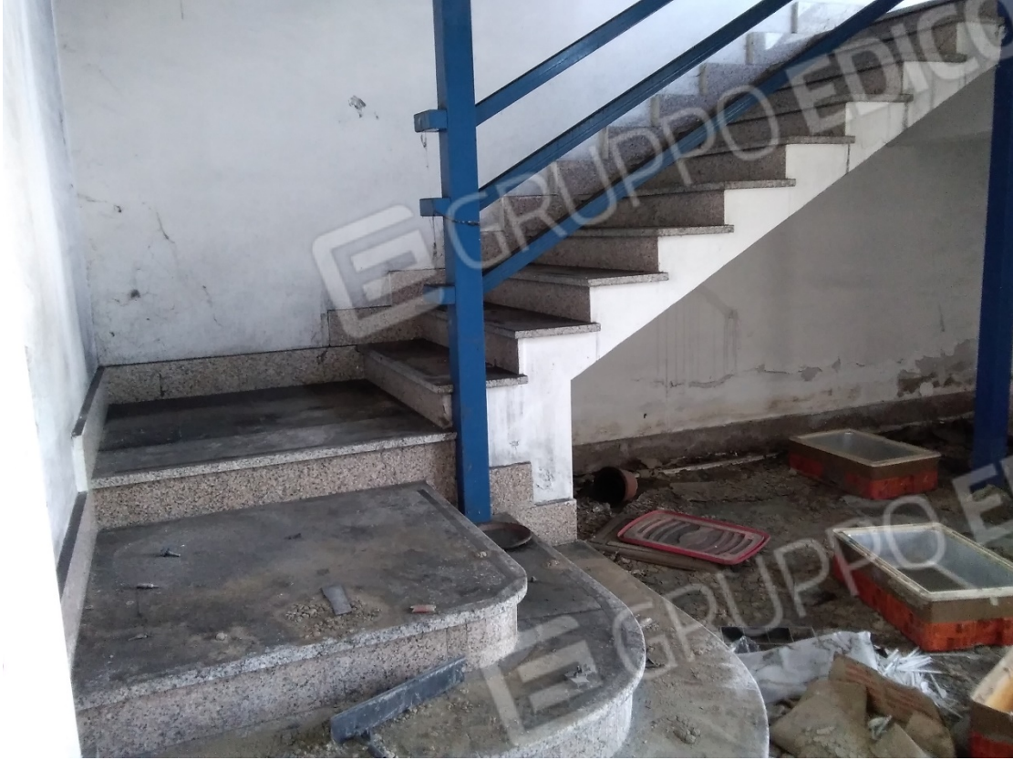
SCALA DI COLLEGAMENTO AL PIANO PRIMO
