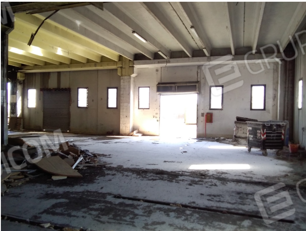
INTERNO OPIFICIO – PIANO TERRA
