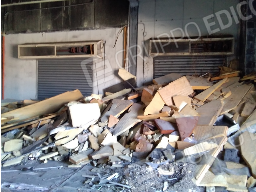
INTERNO OPIFICIO – PIANO TERRA
