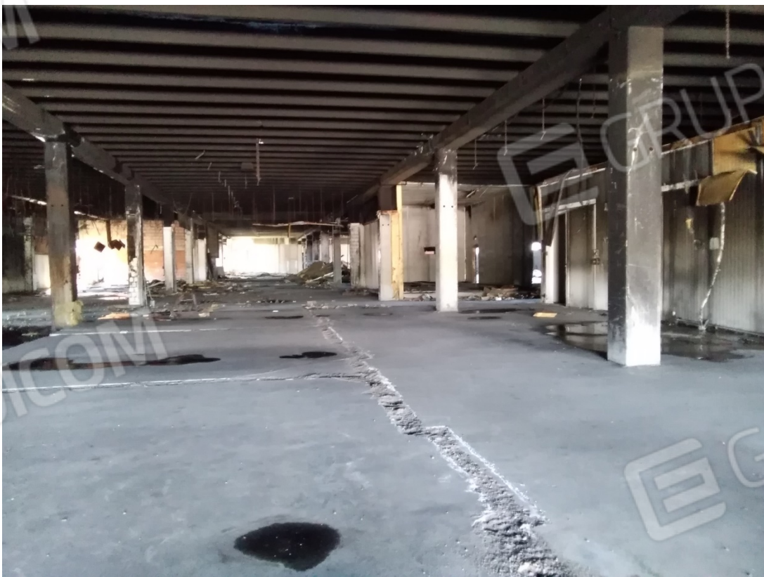
INTERNO OPIFICIO – PIANO TERRA
