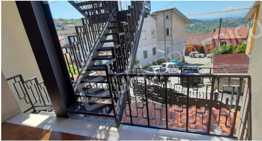
Foto n. 7__Balcone Piano Primo
