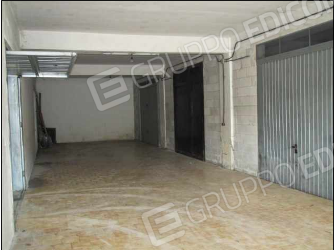
45. Spazi di manovra al piano interrato del fabbricato in Benevento, via Avellino n. 48.
