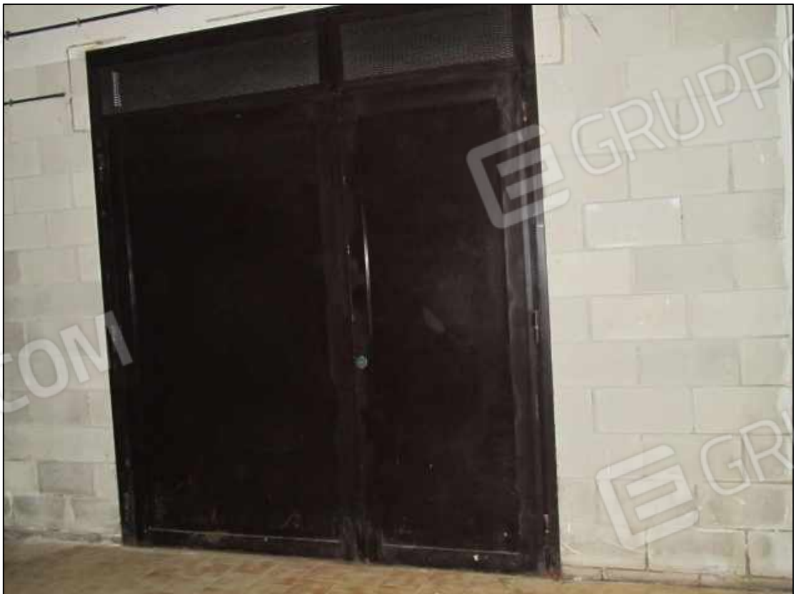
46. Porta d'ingresso al garage al piano interrato del fabbricato in Benevento, via Avellino n. 48 (fg. 101 p.lla 397 sub 10).
